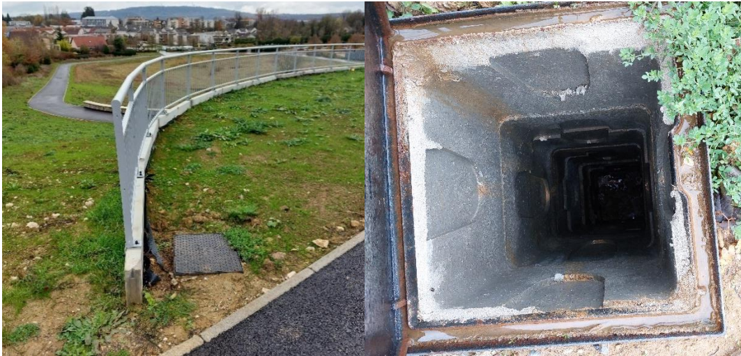
Figure 12 : Photographies d'un mur de soutènement et du réseau de drainage associé - ECR Environnement (Décembre 2023)
