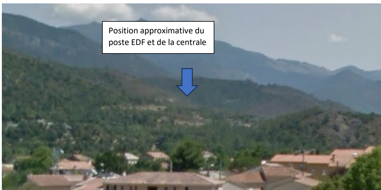
Vue en direction de la centrale, depuis un point haut du hameau n°2 (photo très zoomée en raison de la distance)
