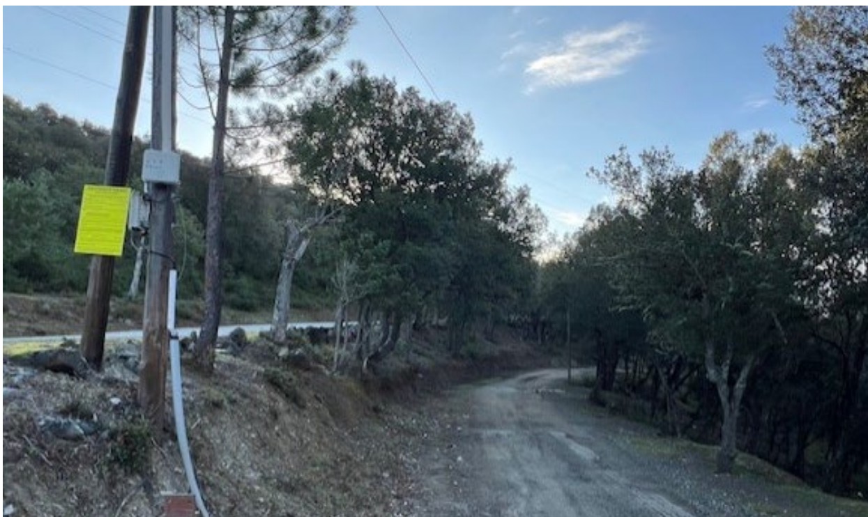
Accès depuis la route départementale, l'avis d'EP était toujours en place le 18 février 2025
