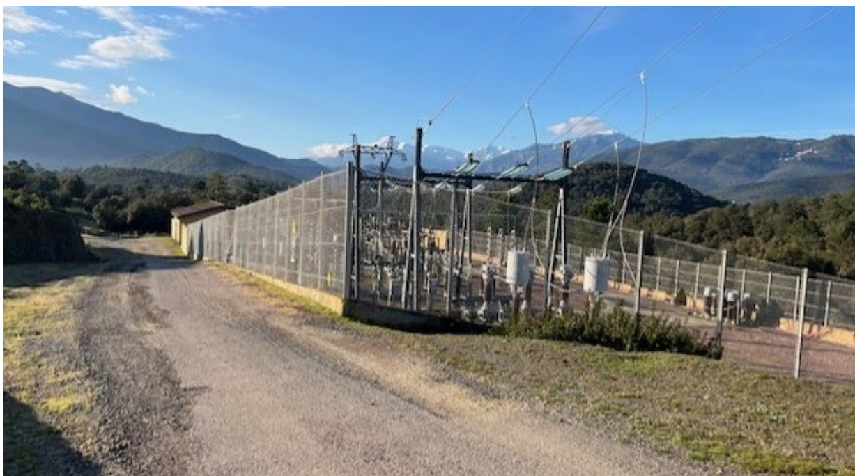
Poste source EDF, mitoyen à la parcelle du projet. Vue sur la piste qui contourne le poste permet d'accéder à l'aire d'étude
