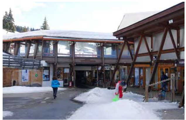
La galerie commerciale agrandie entre la Rive et la résidence Pierre Blanche © archipat, février 2022
