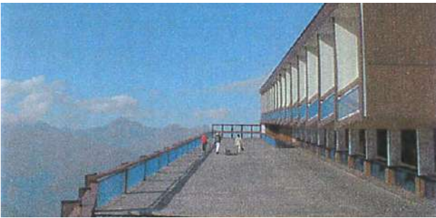
Toiture avec terrasse supérieure
