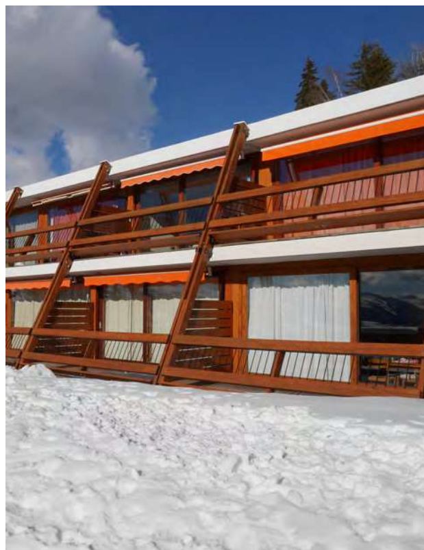
Façade courante de Versant Sud, les stores bannes différents © archipat, février 2022
