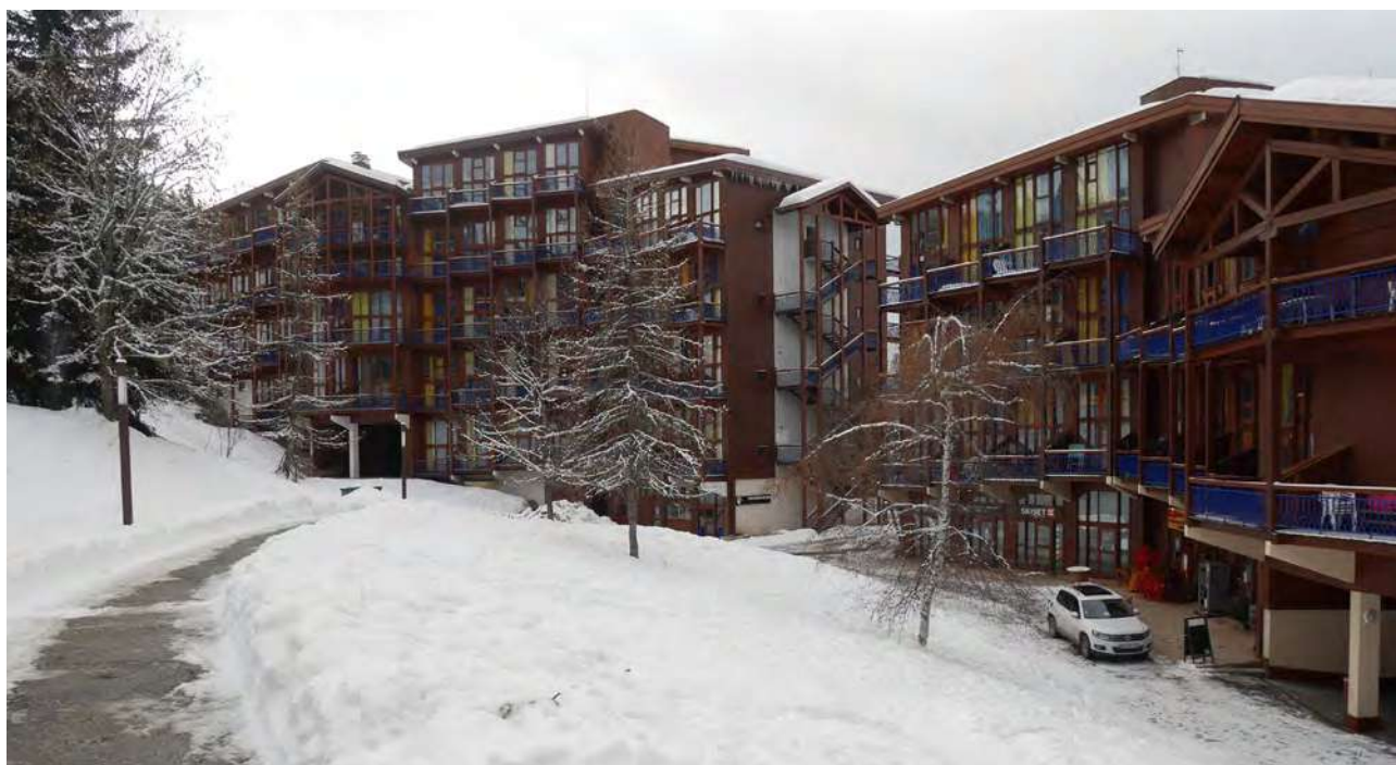
Revêtement de sol des cheminements et des pieds d'immeubles © archipat, octobre 2021
