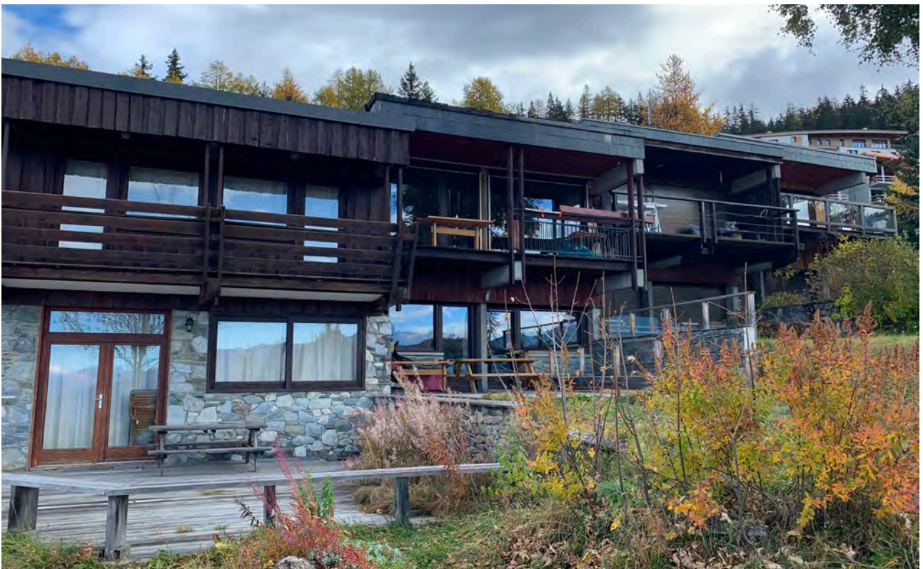
Les modifications des chalets : menuiseries remplacées, garde-corps des balcons, teintes des bois © archipat, octobre 2021
