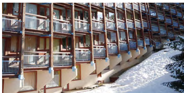
Béton des soubassements et consoles : ici, l'enduit légèrement teinté contraste avec le blanc immaculé de la neige © archipat, janvier 2022
