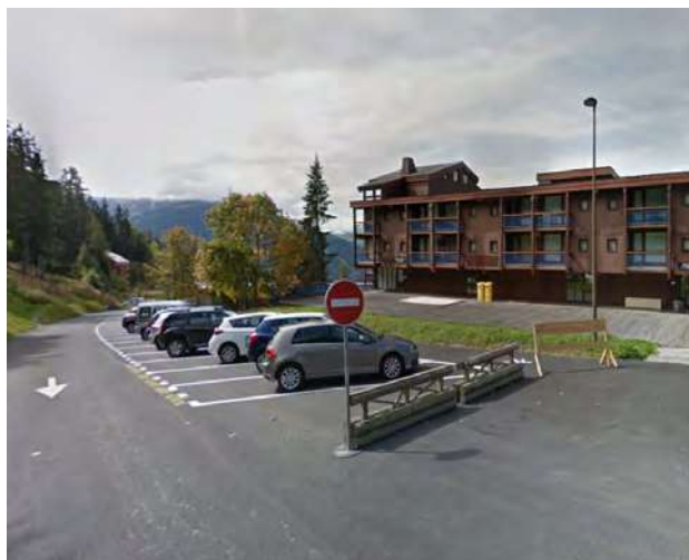
Le parking silo, à gauche la voirie d'accès au parking et à l'Hôtel Mercure, à droite celle du Village Club
