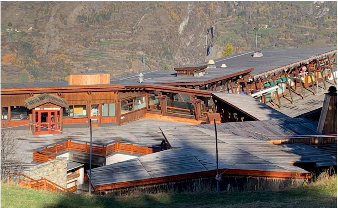
La galerie commerciale prolongée et le restaurant agrandi entre l'entité Place du Soleil et l'entité Place des Trois Ours © archipat, octobre 2021
