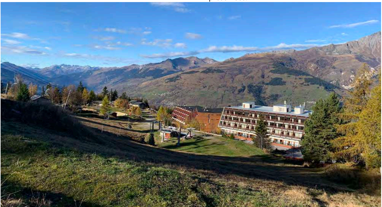
La circulation piétonne au pied des pistes, de l'amont vers l'aval, le long de l'ensemble hôtel et résidence La Cachette © archipat, octobre 2021
