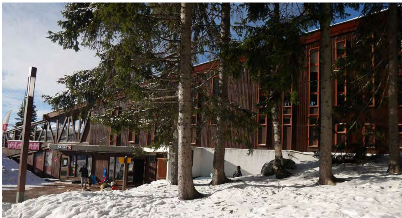
Aile des parties communes de l'Hôtel du Golf © archipat, janvier 2022
