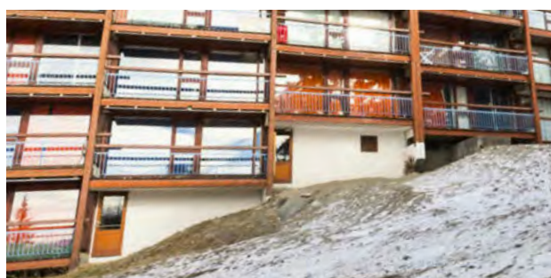
Béton des soubassements et consoles
