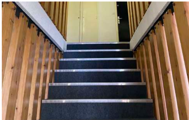
Escaliers de La Cascade © archipat, février 2022
