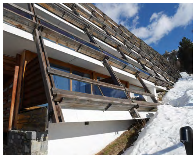
Structure des balcons de La Cascade
