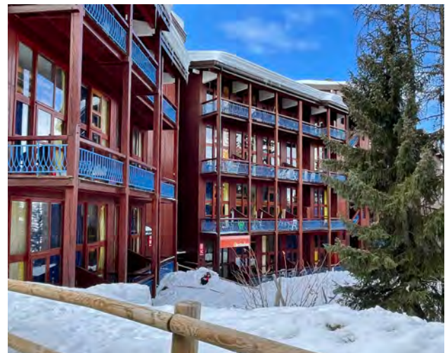
Résidences l'Archeboc © archipat, février 2022
