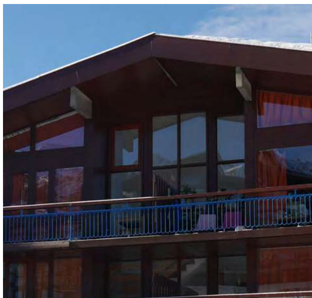
Teinte brun rouge des lasures, châssis ouvrant créé, bandes de rives épaisses © archipat, janvier 2022
