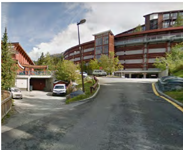
Les sorties de parking et garages du silo et du Village Club directement sur une voirie permettant de redescendre au pied de la station © Google
