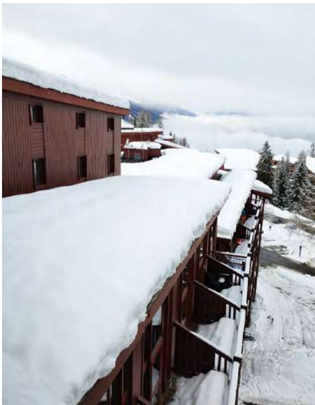
Toitures des résidences de l'Aiguille Grive en hiver © CAUE 73
