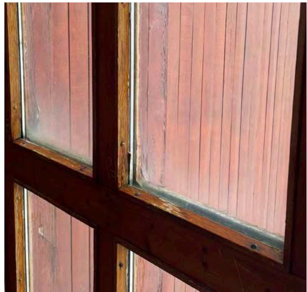
Jointes entre les menuiseries et le double vitrage retirés © archipat, janvier 2022
