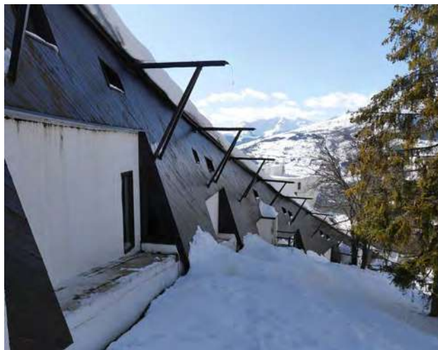
Façade nord de La Rive © archipat, février 2022
