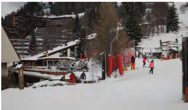
Le chemin émergeant de la rue commerçante en pied d'immeuble et le chemin amont aux pieds des pistes © archipat, janvier 2022
