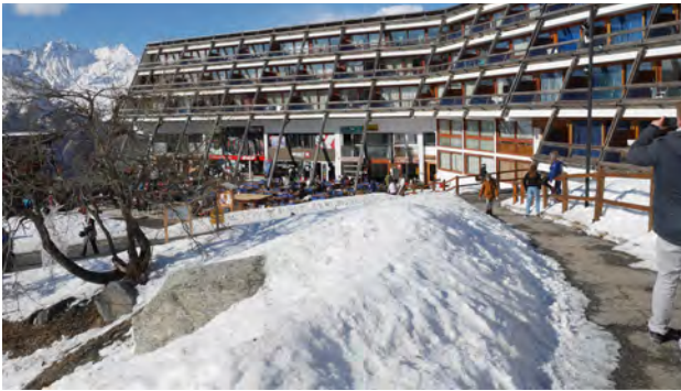
Circulation piétonne aval/amont le long de l'immeuble La Cascade © archipat, février 2022
