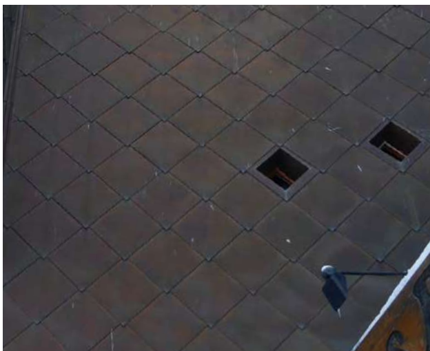
Écailles de cuivre oxydées © archipat, janvier 2022
