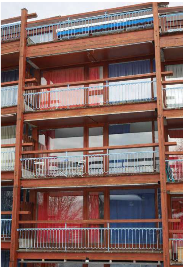
Menuiseries et serrureries de la résidence La Nova © archipat, janvier 2022
