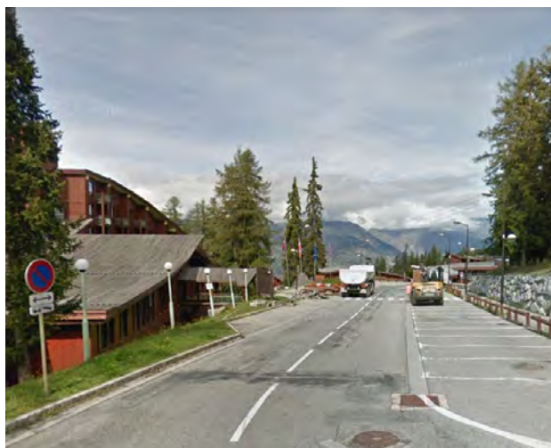
Entrée de l'Hôtel Mercure, voirie et stationnements en amont © Google
