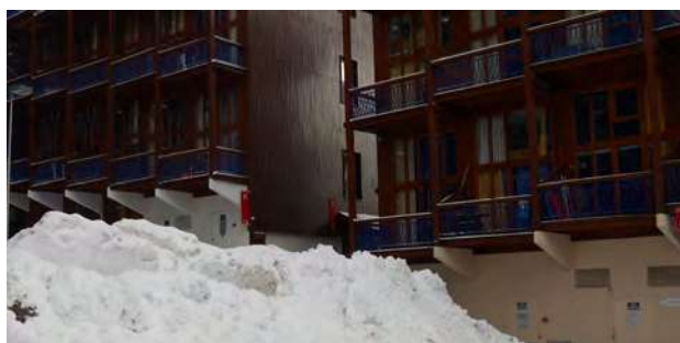
Béton des soubassements et consoles © archipat, janvier 2022
