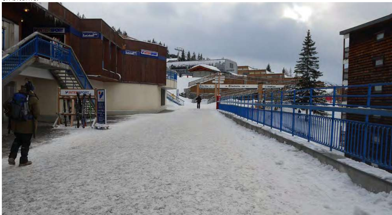
Plateforme piétonne reliant la gare de funiculaire au cœur de l'entité © archipat, janvier 2022
