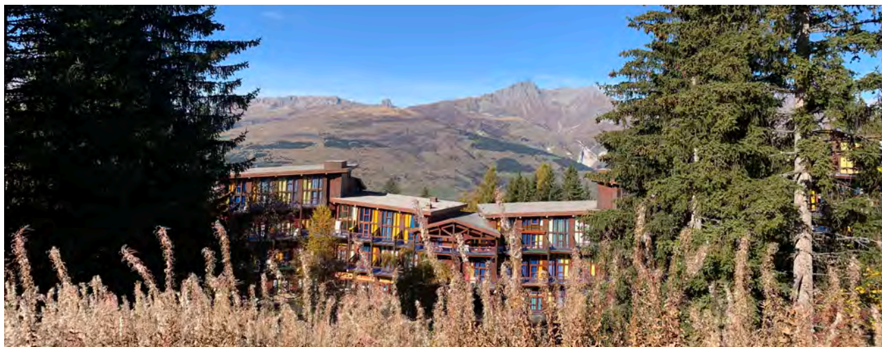
Résidences de l'Aiguille Grive au cœur de la forêt et face aux montagnes © archipat, octobre 2021
