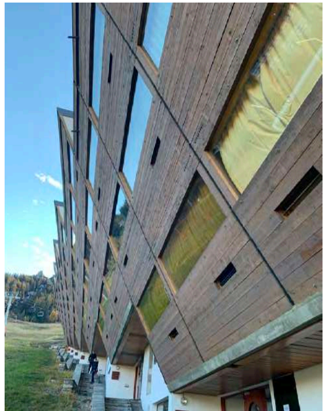
Façade nord de La Cascade © archipat, octobre 2021
