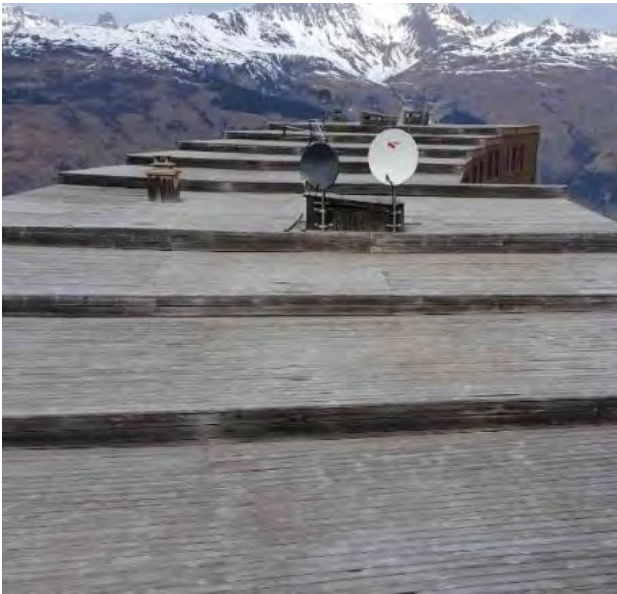
Porte neige en lames de mélèzes conservé, paraboles et antennes rapportées © ENEOS, 2017
