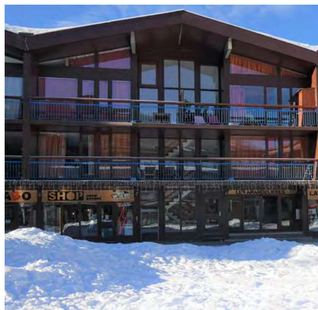
Façade courante des Arandelières © archipat, janvier 2022
