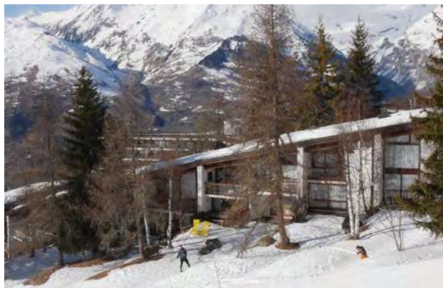
Façade sud de La Rive © archipat, février 2022
