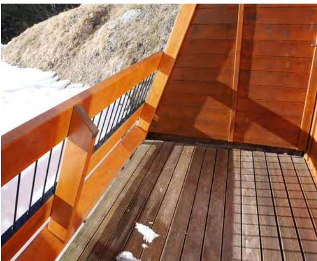
Balcons des édifices Versant Sud © archipat, février 2022
