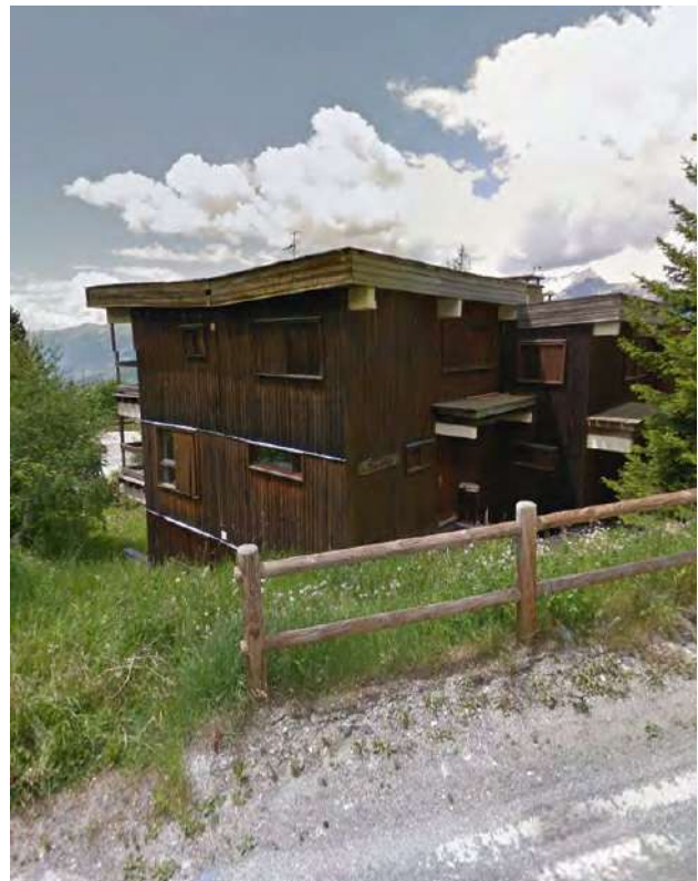
La façade nord-est des chalets
