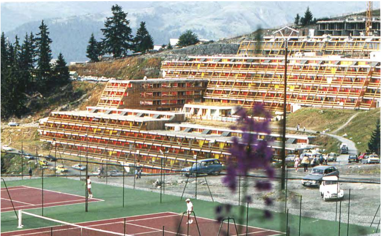
L'entité Versant Sud encore en chantier pour le bâtiment le plus en amont : 1973/1974 © Catherine Taillefer
