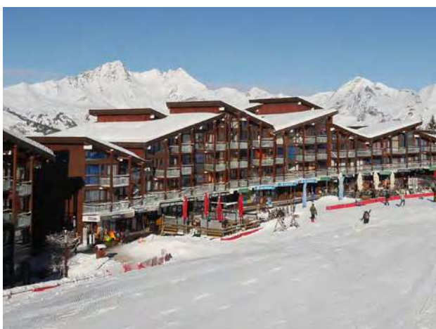
La galerie commerçante et les terrasses sur la grenouillère © archipat, janvier 2022
