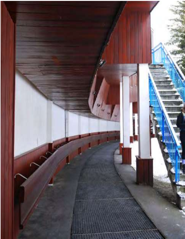
Coursive le long de La Nova © archipat, janvier 2022
