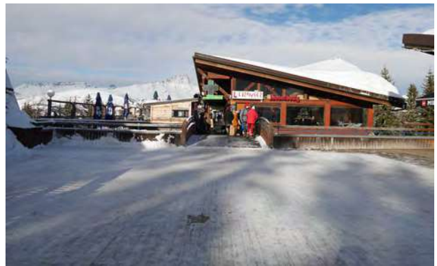
La passerelle d'accès à la toiture du Miravidi © archipat, janvier 2022
