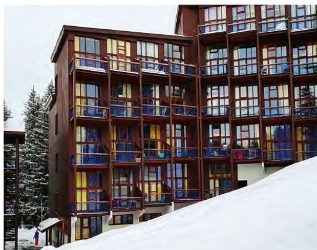
Bois des menuiseries et structures des balcons, vitrages et rideaux © CAUE 73
