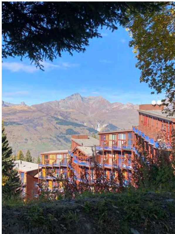
Toitures des résidences de l'Aiguille Grive © archipat, octobre 2021
