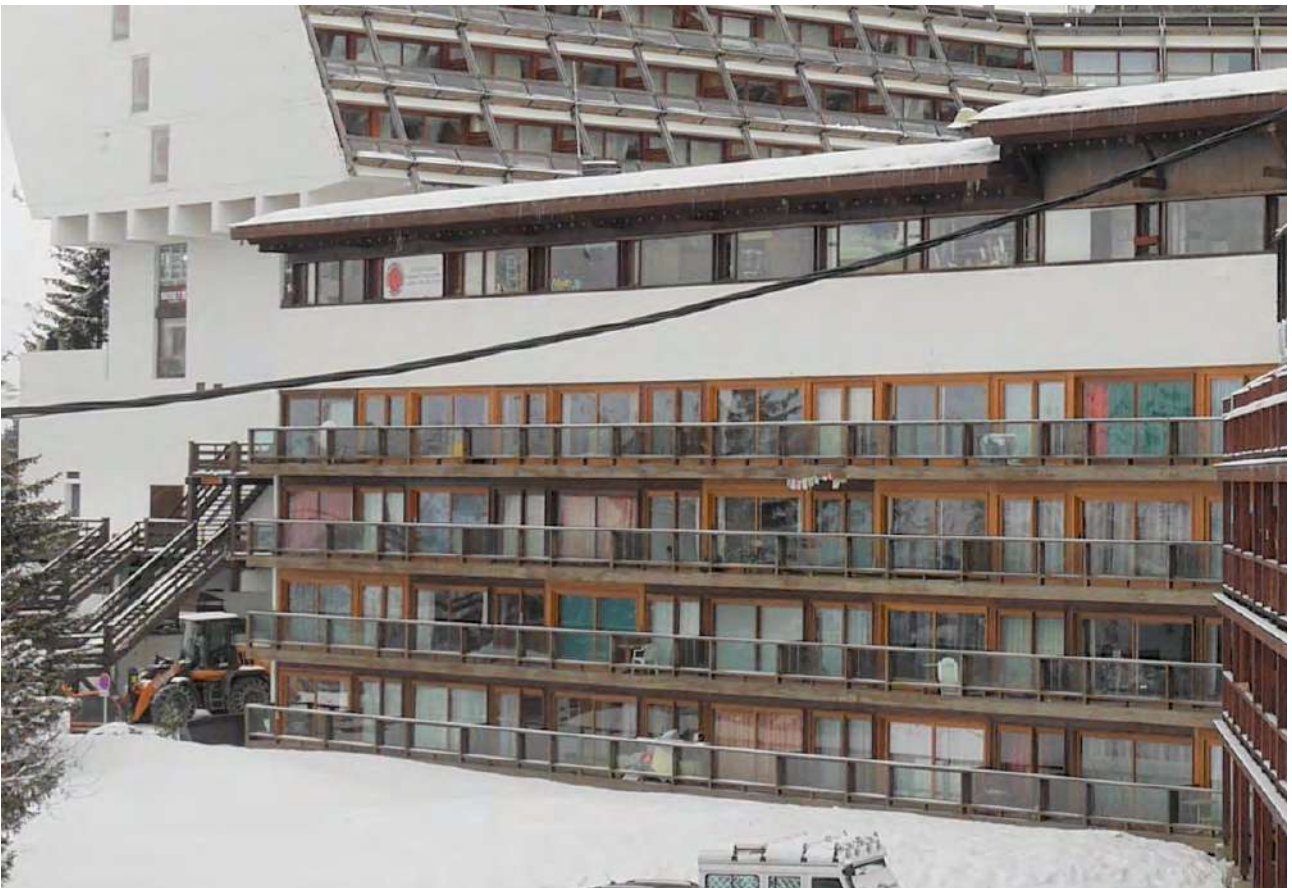
La résidence Pierre Blanche surmontée par la galerie commerciale © archipat, janvier 2022
