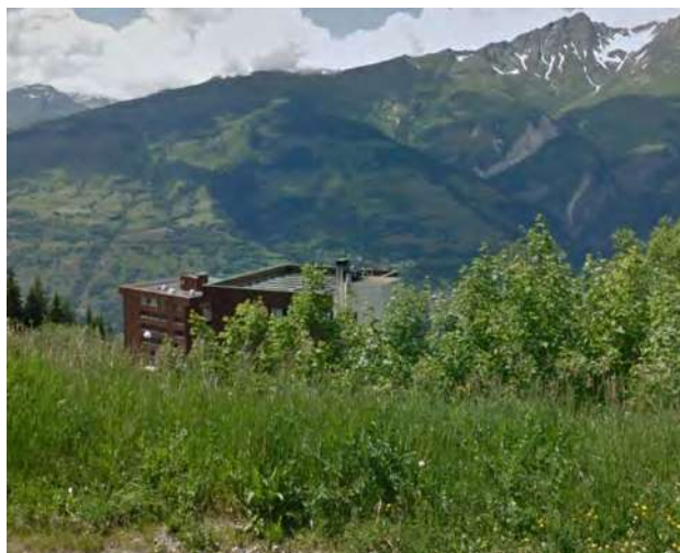
Les toitures terrasses des résidences Plan Devin depuis la station © Google
