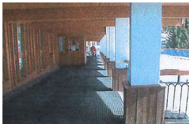
Rampe de distribution extérieure du Pierra Menta © Région Rhône-Alpes, Inventaire général du patrimoine culturel © Ecole d'architecture de Grenoble - Lyon-Caen Jean-François - Salomon-Pelen Catherine
