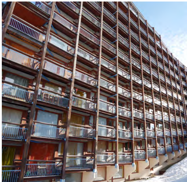
Les teintes variées des rideaux, les soubassements légèrement teintés (préférer le blanc) © archipat, janvier 2022
