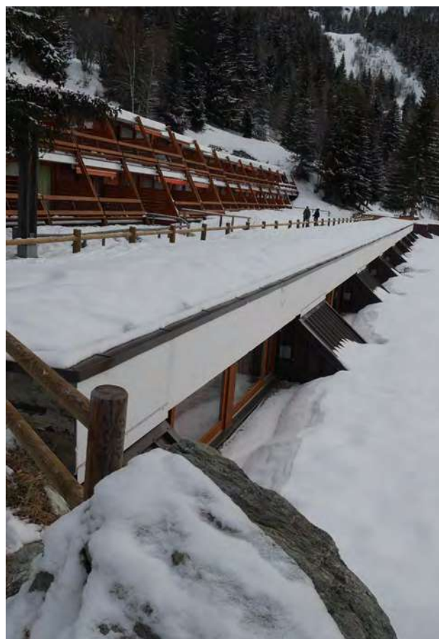
Les toitures et rives des ensembles Versant Sud © archipat, janvier 2022
