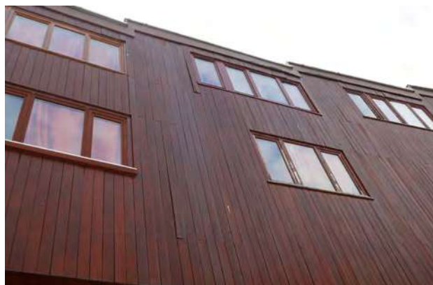
Bardage bois à lames verticales © archipat, janvier 2022
