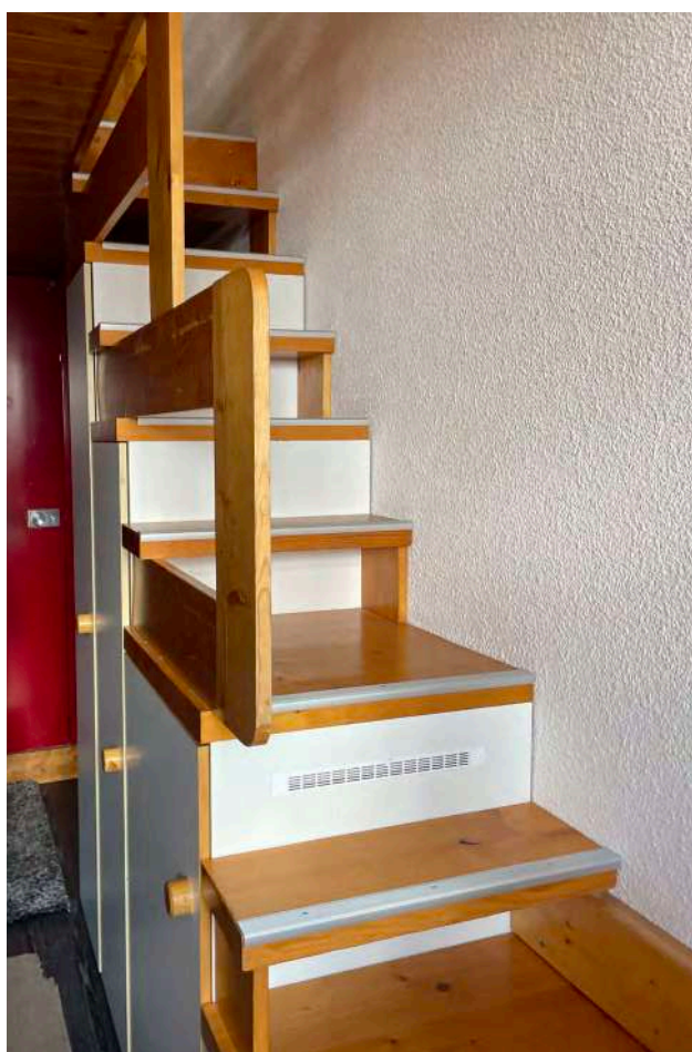
Escalier d'un appartement de l'Aiguille Grive 1 conservée ©archipat, février 2022
