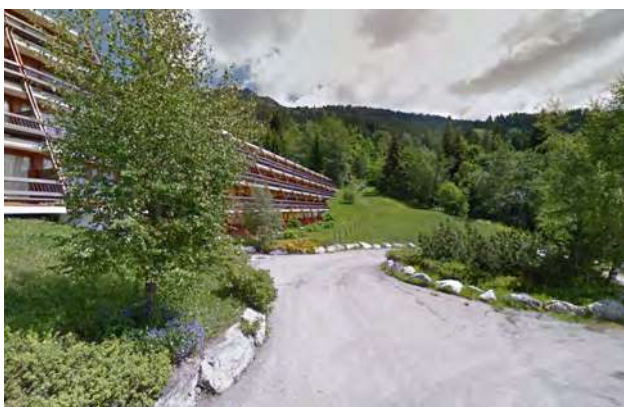
L'accès à Versant Sud, en impasse © Google
