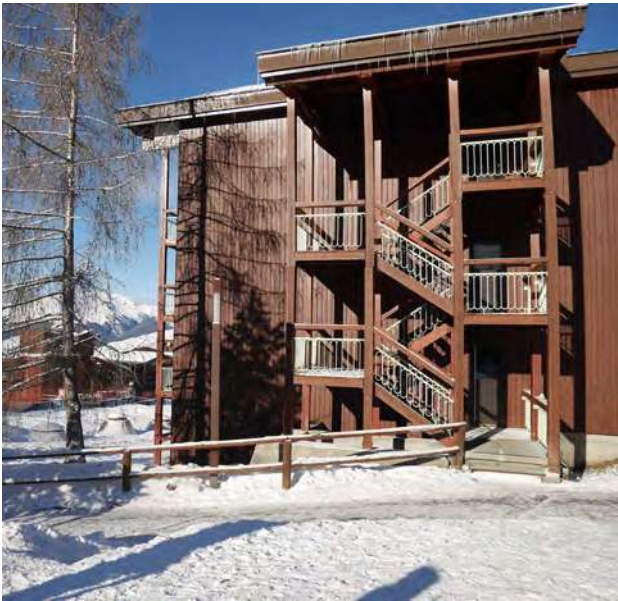
Bardage bois et escaliers extérieurs des Tournavelles © archipat, janvier 2022
