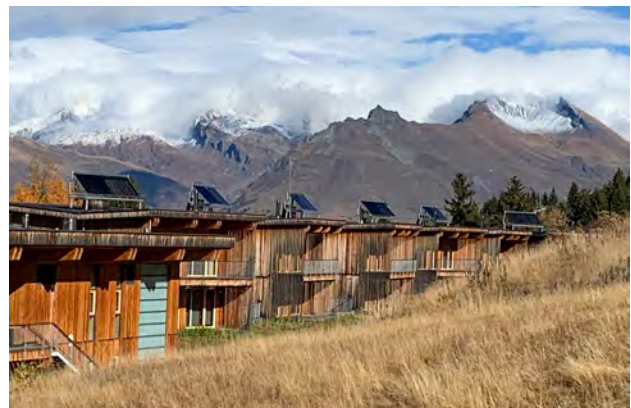
Les nouveaux Chalets Hotels de l'Aiguille Grive avec panneaux solaires © archipat, octobre 2021
