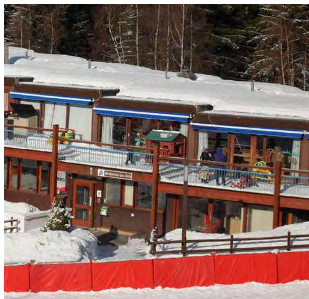
Les menuiseries remplacées de la garderie © archipat, janvier 2022
