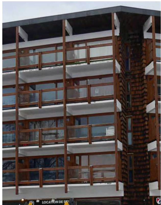
Les dalles de balcons des Trois Arcs © archipat, janvier 2022
