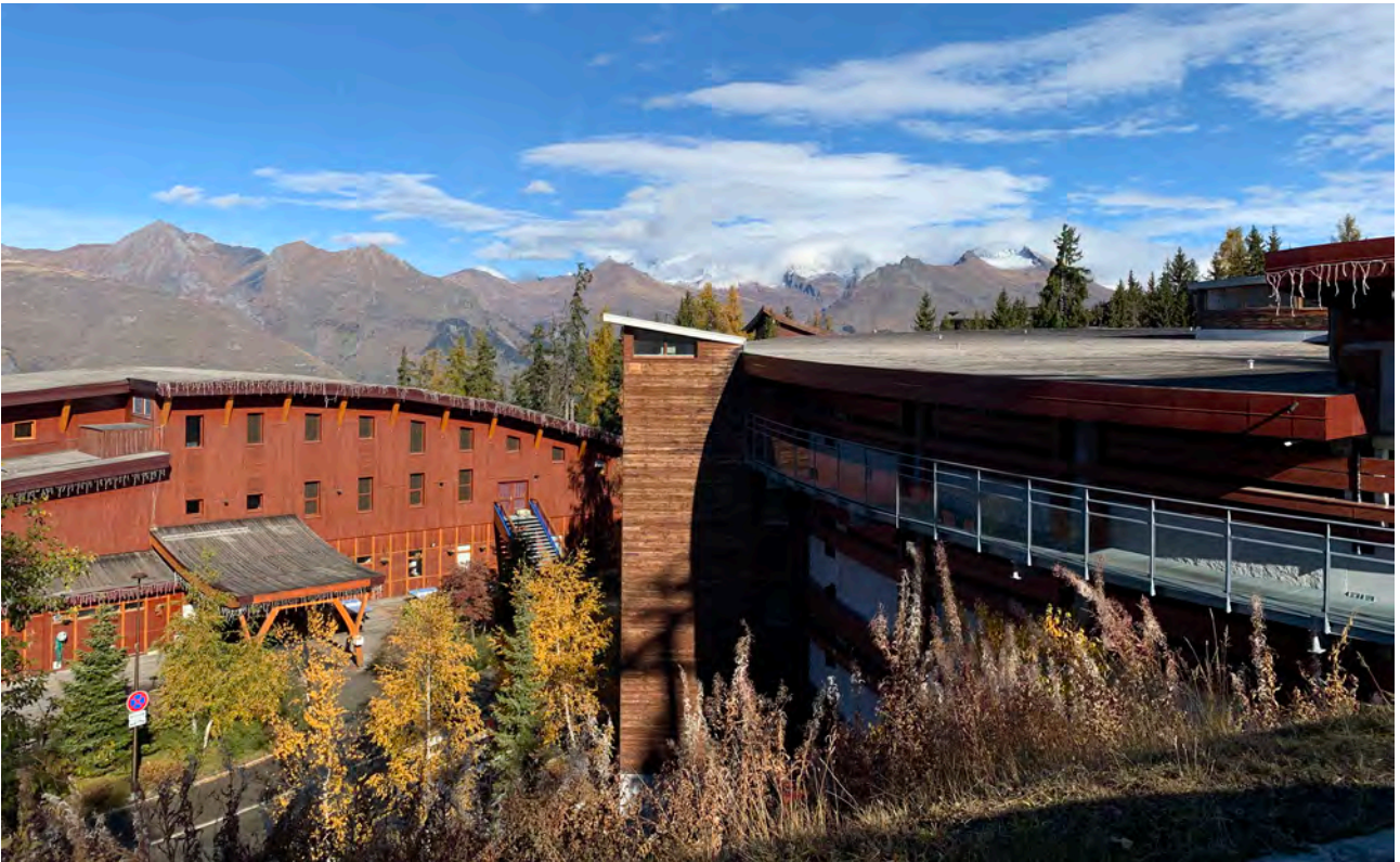
A droite le parking silo construit postérieurement, à gauche l'Hôtel Mercure Gran Paradiso © archipat, octobre 2021
