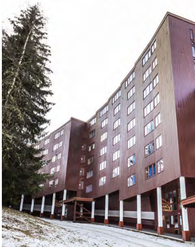
La Nova, façade nord-est
