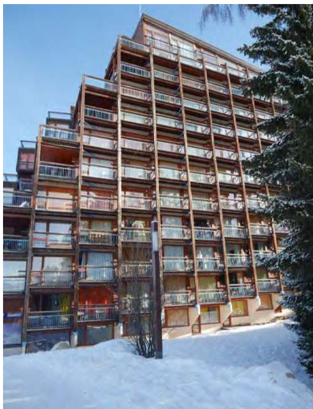
Façades des Belles Challes © archipat, février 2022
