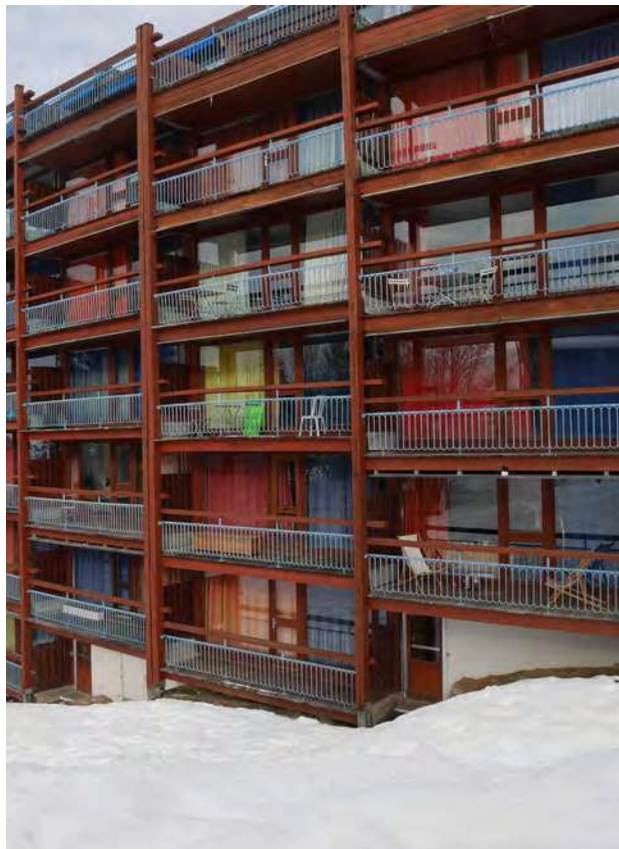
Les balcons émergeant de la pente sur la face convexe de la résidence © archipat, janvier 2022
