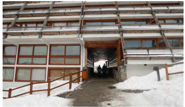
Passage de l'axe piéton sous La Cascade © archipat, janvier 2022
