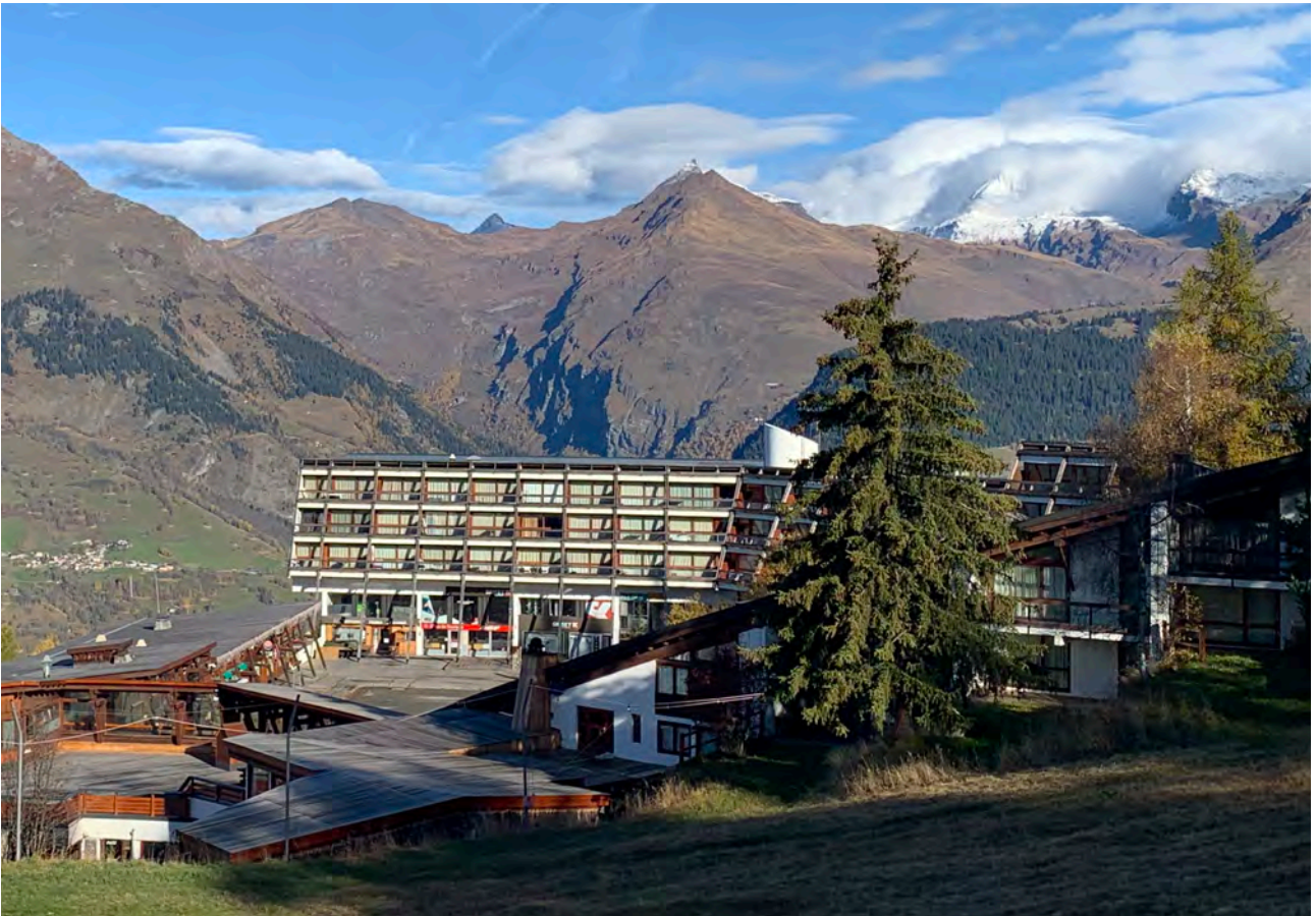
Entité Place du Soleil, Cascade et Rive depuis l'amont © archipat, octobre 2021
