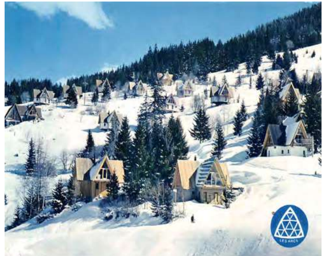
Les Chalets Pointus à leur construction, certains en travaux © Delcampe, Cartalis, Les Arcs Bourg-Saint-Maurice
