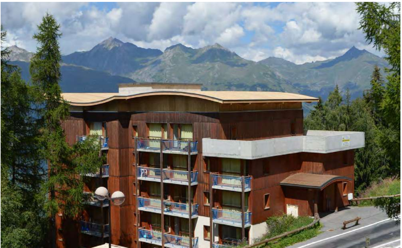
Le Val Sapioux et sa toiture porte neige ondulée
