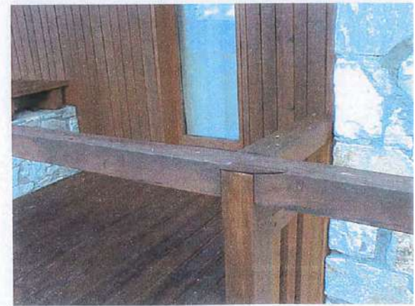
terrasses et garde-corps
