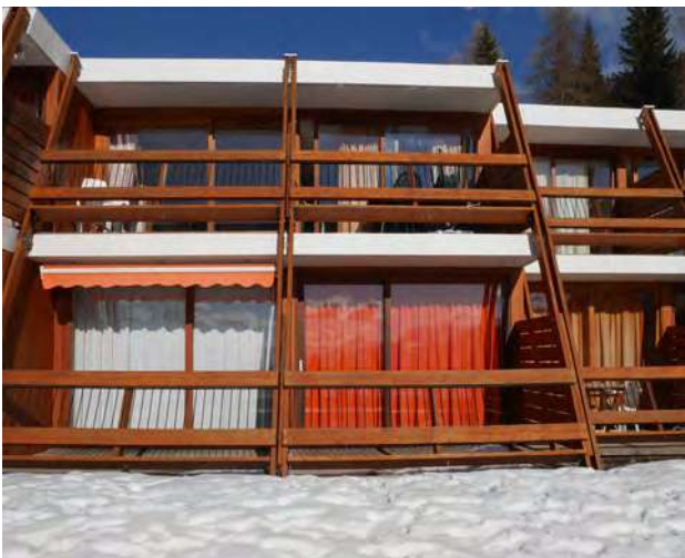
Vue rapprochée des façades de Versant Sud © archipat, février 2022
