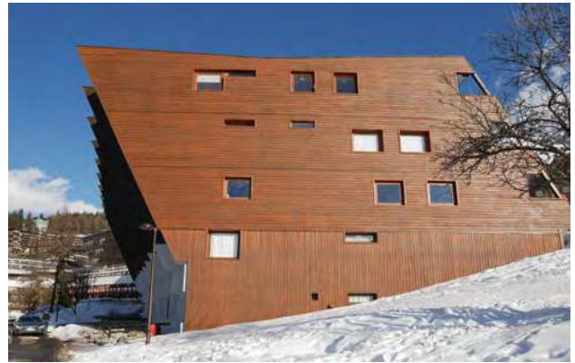
Les ouvertures créées dans le pignon de la résidence La Cachee © archipat, février 2022
