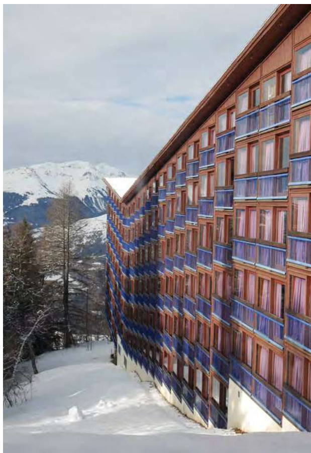
Aile des chambres de l'Hôtel du Golf © archipat, janvier 2022
