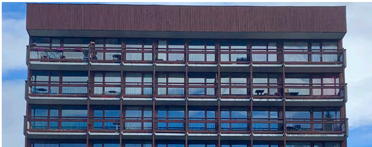
Plan Devin 1, façade sud-ouest essentiellement constituée de menuiseries bois toute hauteur avec un large châssis fixe et une porte vitrée donnant sur le balcon. L'épaisse rive de toiture bardée de bois. Les garde-corps des balcons en bois et barreaudages métalliques. Les rideaux bleus. © archipat, octobre 2021
