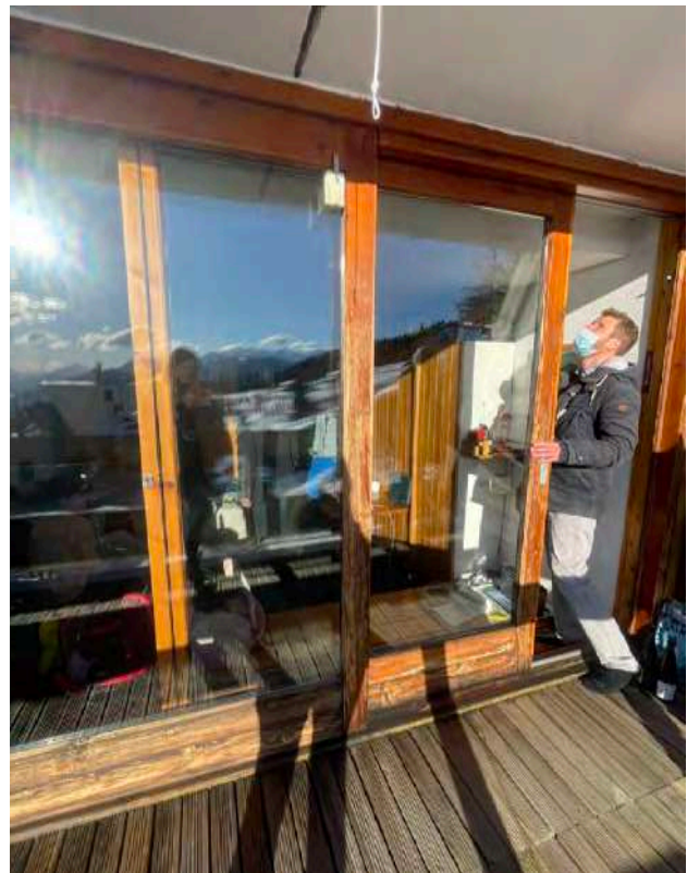
Menuiseries de La Cascade © archipat, février 2022
