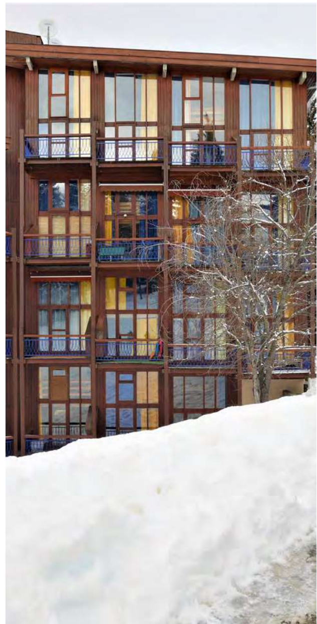
Façades des résidences de l'Aiguille Grive © archipat, janvier 2022
