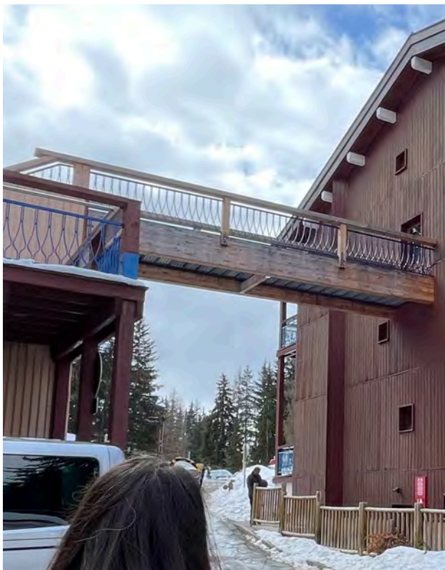
La passerelle entre le Belmont et l'Archeboc © archipat, février 2022
