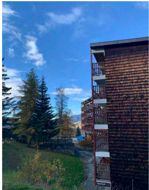
Pignon est et façade sud de la résidence Trois Arcs © archipat, octobre 2021
