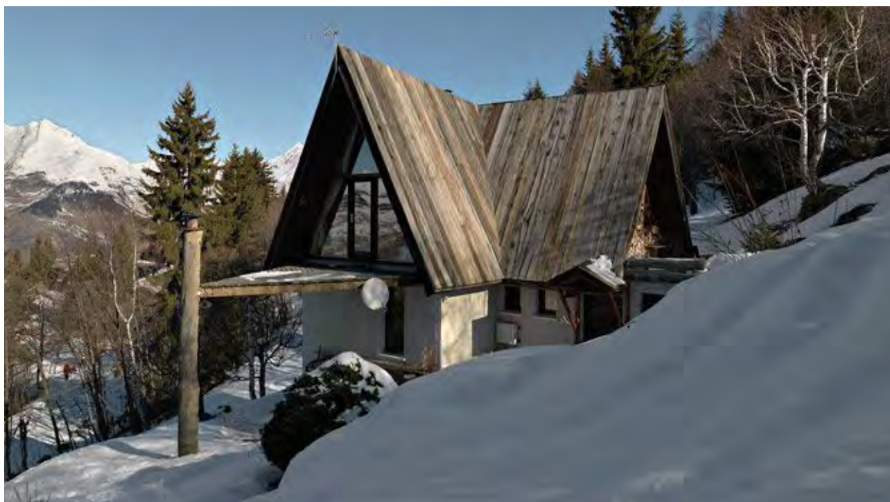
Le soubassement maçonné et l'étage en charpente bois
