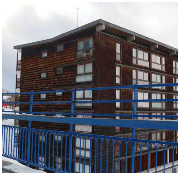
La toiture à deux pans inversés de la résidence Trois Arcs © archipat, janvier 2022
