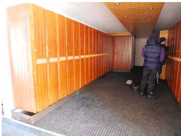
Les placards à skis dans les halls d'entrée © archipat, février 2022
