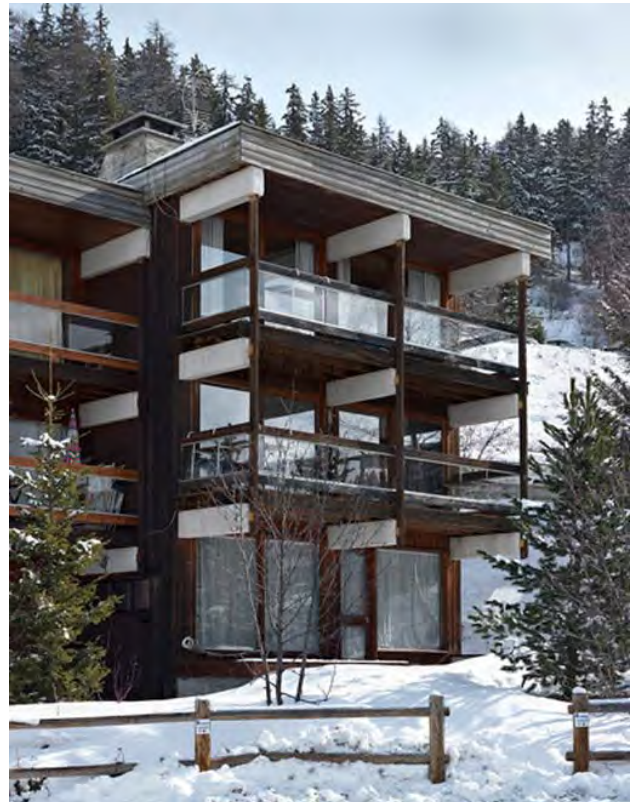
La façade sud-ouest des chalets
