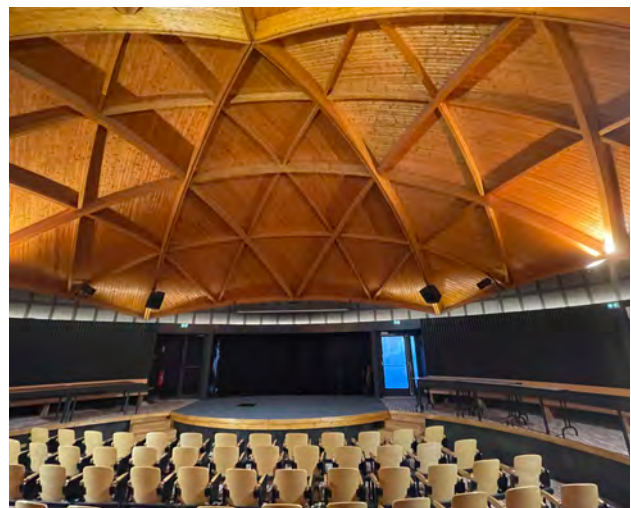
La Coupole et sa charpente triangulée © archipat, février 2022
