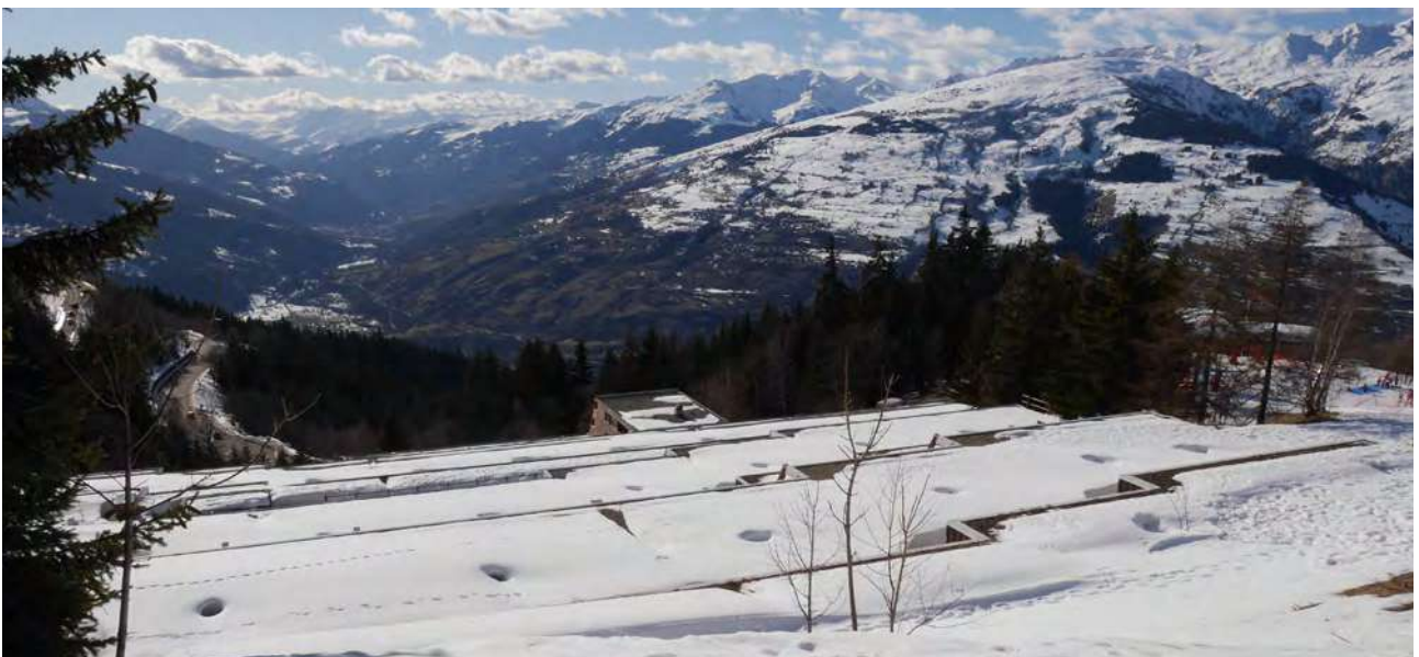
Les toitures de l'entité Versant Sud en hiver et la vue vers la vallée © archipat, février 2022
