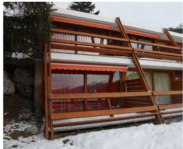
Structure des balcons de l'entité Versant Sud
