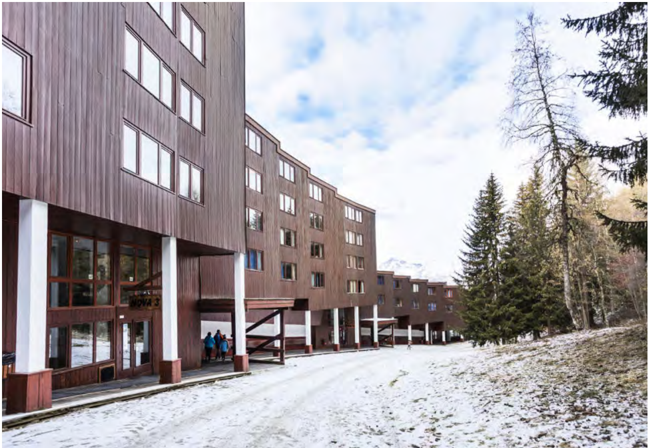
La Nova, façade nord-est
