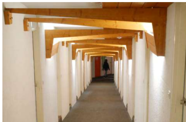
Rampe centrale des Lauzières © archipat, janvier 2022
