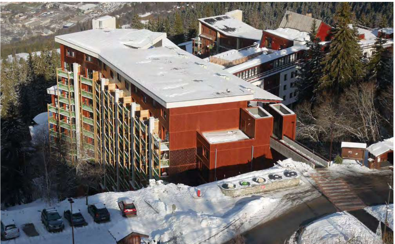
L'entité Charvet Bas depuis l'amont, La Croisette au premier plan © archipat, janvier 2022
