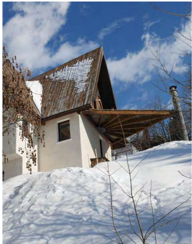
Un chalet pointu, son soubassement enduit, ses façades à lames de mélèzes et sa terrasse triangulaire © archipat, février 2022
