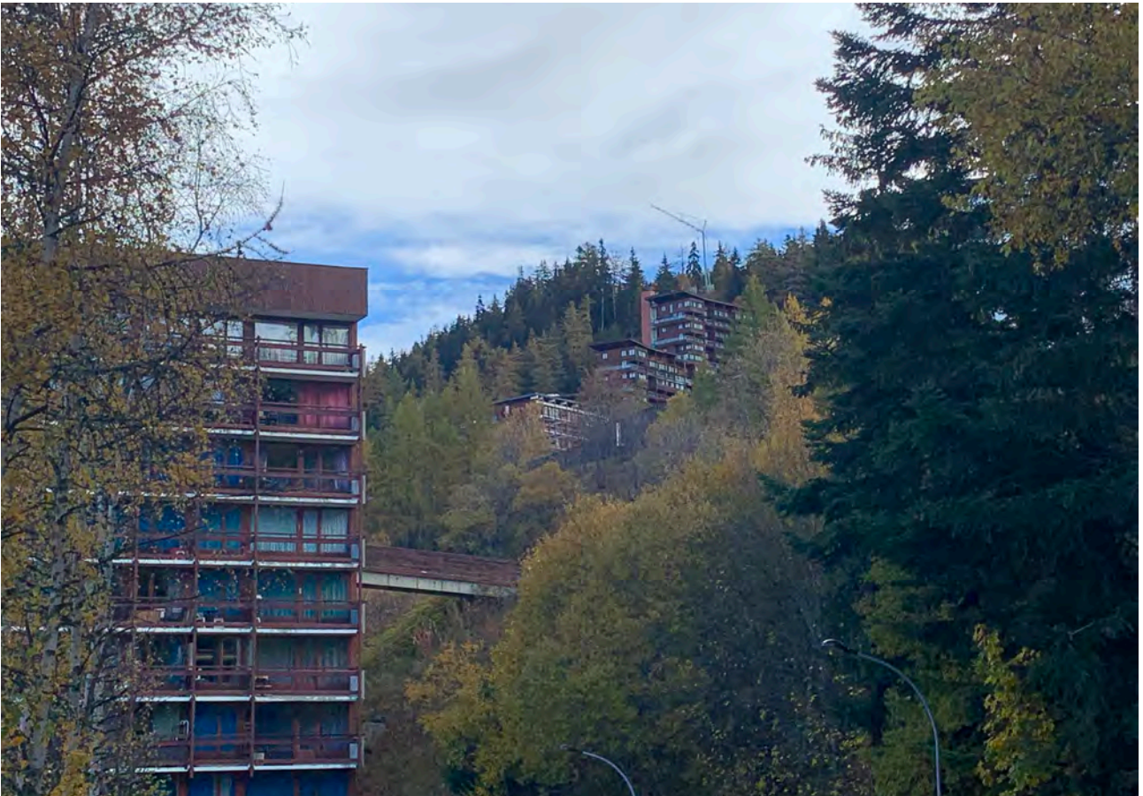
Plan Devin 1 en contrebas de la station et sa passerelle pour relier la route principale © archipat, octobre 2021
