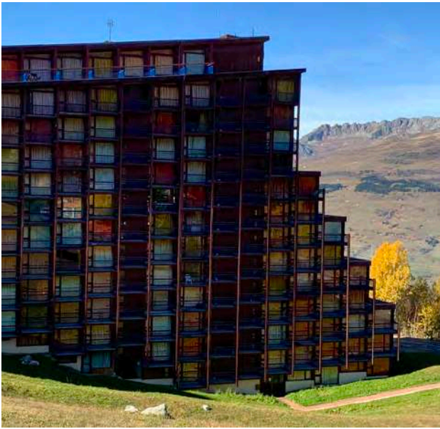
Façade du Pierra Menta © archipat, octobre 2021
