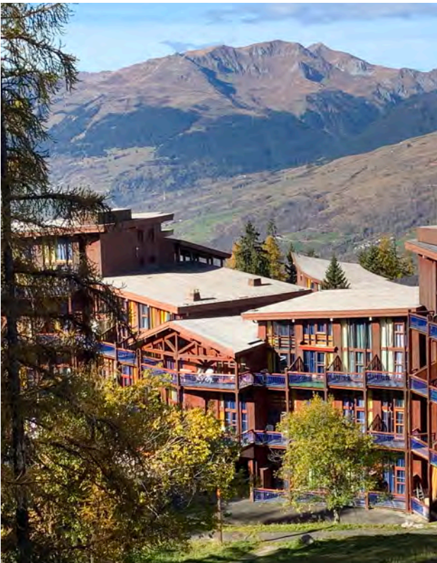
Résidences de l'Aiguille Grive depuis l'amont © archipat, octobre 2021
