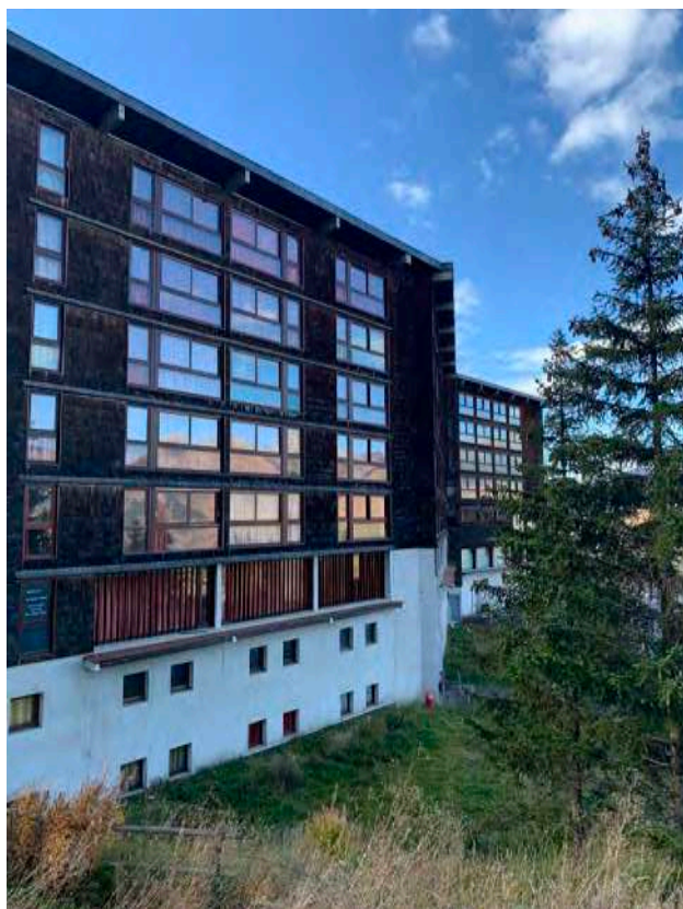
Façade nord de la résidence des Trois Arcs © archipat, octobre 2021
