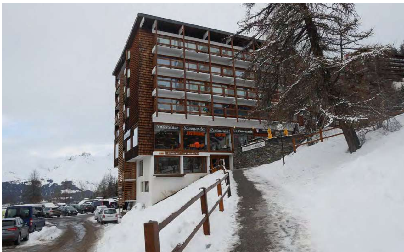
La résidence Trois Arcs, les parkings à son pied et les cheminements piétons pour gagner la station © archipat, janvier 2022
