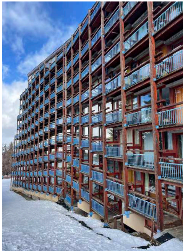
Les Belles Challes : le soubassement en béton émerge entre la pente et les balcons © archipat, janvier 2022
