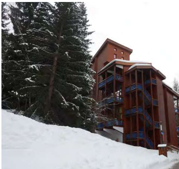
Résidences des Mirantins au cœur de la forêt et face aux montagnes © archipat, janvier 2022
