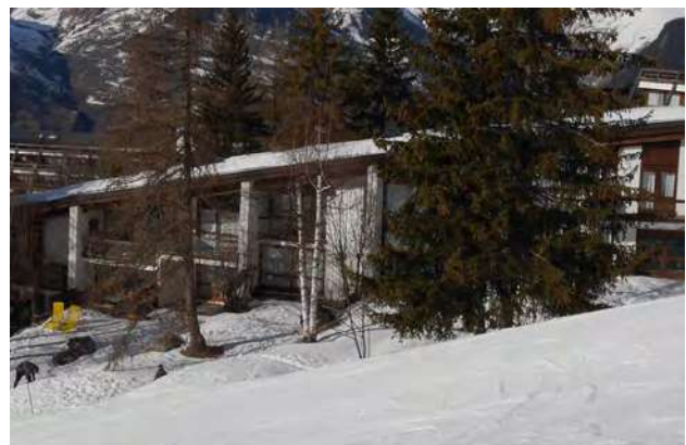
Menuiseries différentes d'un appartement à l'autre sur La Rive (teintes et profils) © archipat, février 2022
