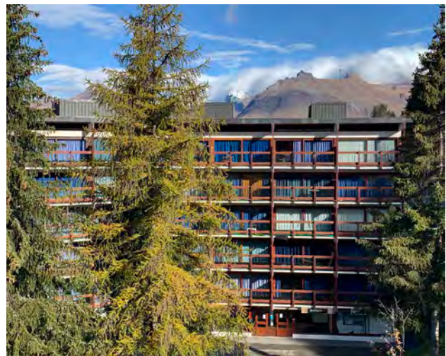
Résidence les Trois Arcs © archipat, octobre 2021
