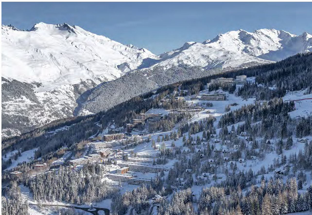
Vue aérienne d'ensemble d'Arc 1600, l'entité Versant Sud tournée vers la Vallée, légèrement à l'écart du cœur de station © Les Arcs, Bourg-Saint-Maurice
