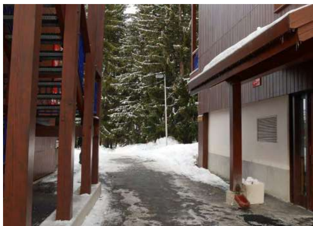
Les cheminements piétons aux abords de l'entité © archipat, janvier 2022
