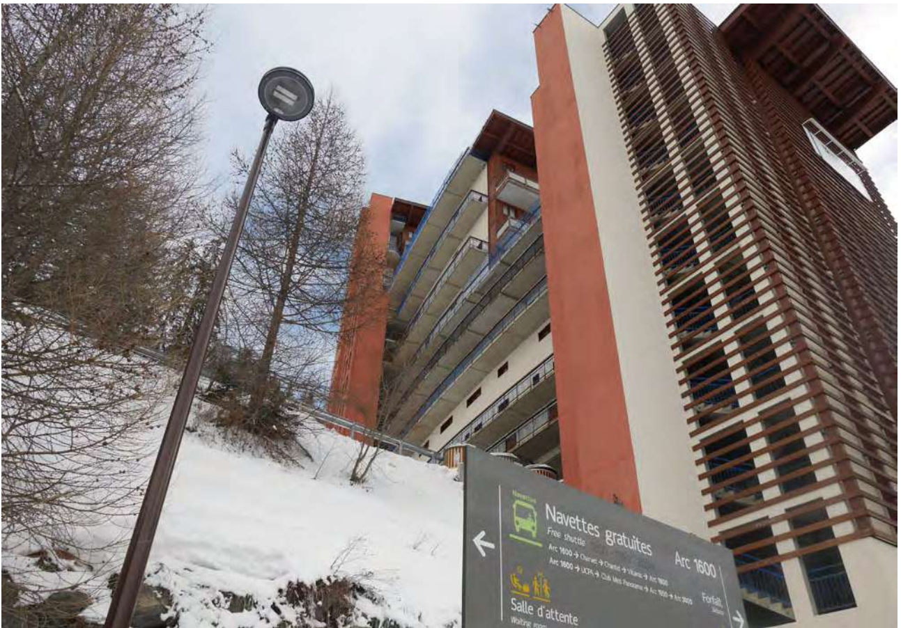
Façade nord du Roc Belleface © archipat, janvier 2022
