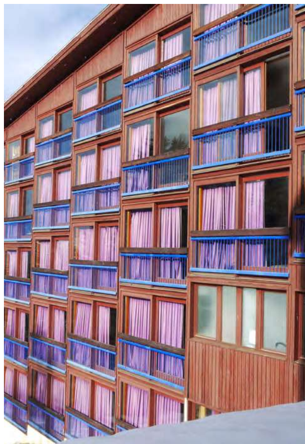
Menuiseries bois, serrurerie et bardages de l'Hôtel du Golf © archipat, janvier 2022
