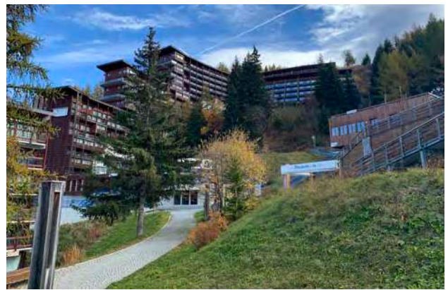
Les espaces publics entre la résidence les Trois Arcs et l'école primaire Pierre Blanche © archipat, octobre 2021
