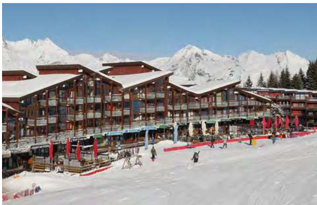
Les terrasses sur la grenouillère © archipat, janvier 2022
