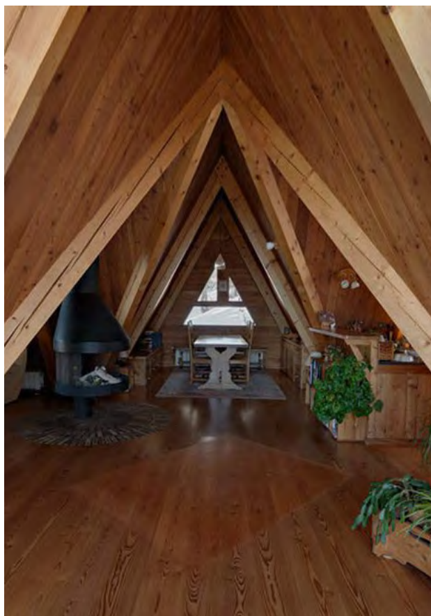
La charpente en bois des Chalets Pointus
