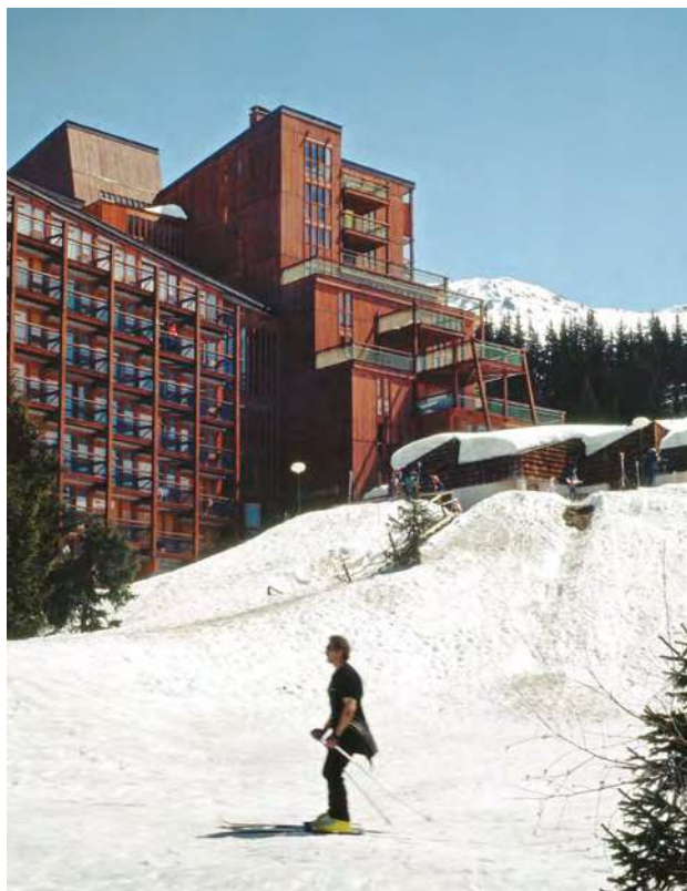
Jonction et entrée du hall entre les Belles Challes et les Lauzières © Pernelle Perriand-Barsac, archives Charlotte Perriand
