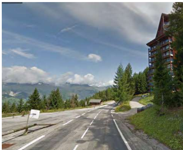
La voirie principale en aval du Ruitor : à gauche l'accès au parc de stationnement public aérien, à droite l'accès au parking aval du Ruitor
