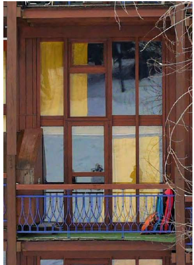
Un dispositif modifié : ouvrant, plancher de mezzanine prolongé et rideaux scindés en deux niveaux © archipat, janvier 2022
