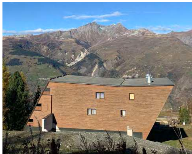
Toitures actuelles de La Cascade en bac acier © archipat, octobre 2021
