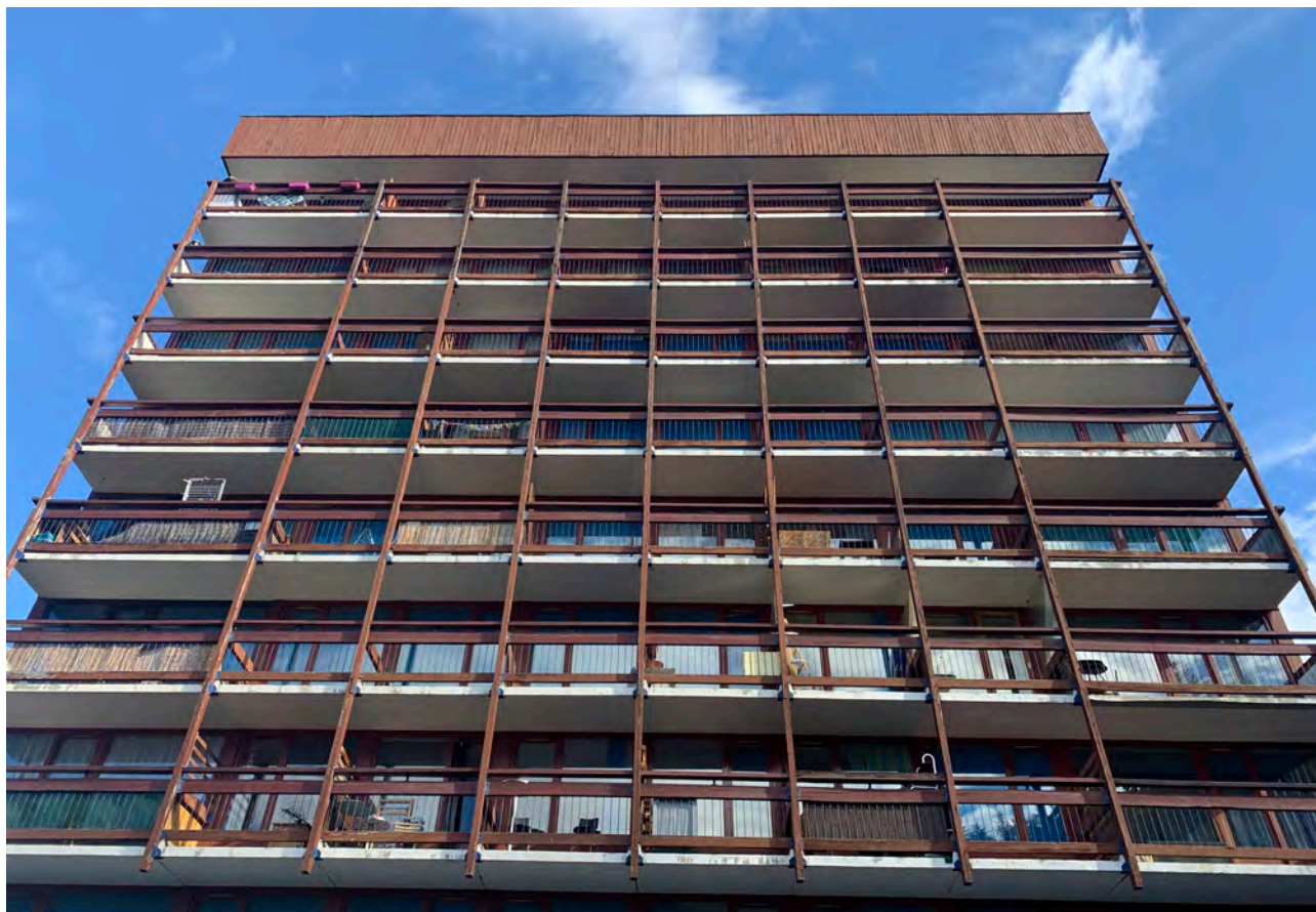
Les balcons de Plan Devin 1 en façade sud-ouest © archipat, octobre 2021
