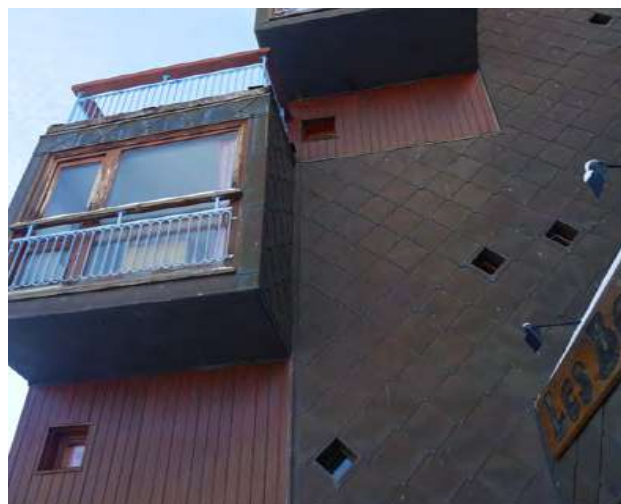
Les bardage bois à lames verticales et les écailles de cuivre sur les Belles Challes © archipat, janvier 2022
