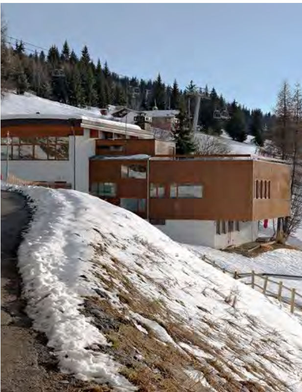
École d'Arc Pierre Blanche © Région Rhône-Alpes, Inventaire général du patrimoine culturel © Ecole d'architecture de Grenoble - Lyon-Caen Jean-François - Salomon-Pelen Catherine
