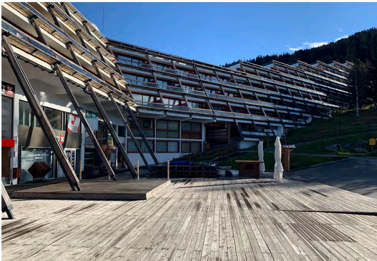
La façade sud et la "cassure" entre La Cascade et Les Arolles © archipat, octobre 2021
