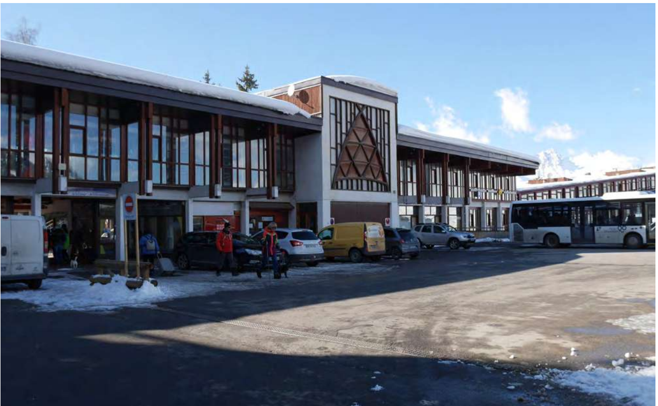
Entrée de station © archipat, février 2022
