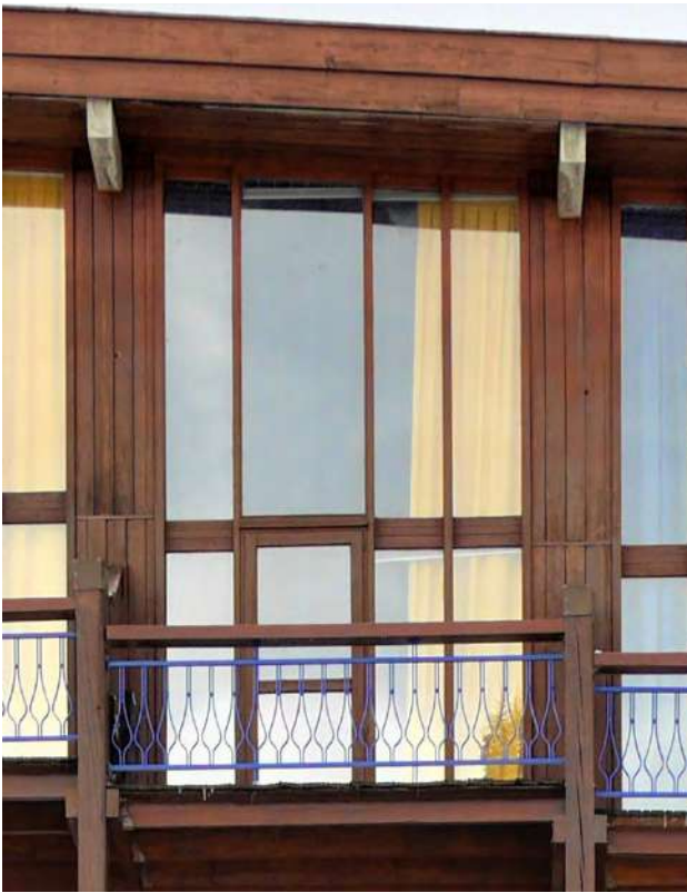
Façade d'un appartement : dispositif d'origine © archipat, janvier 2022
