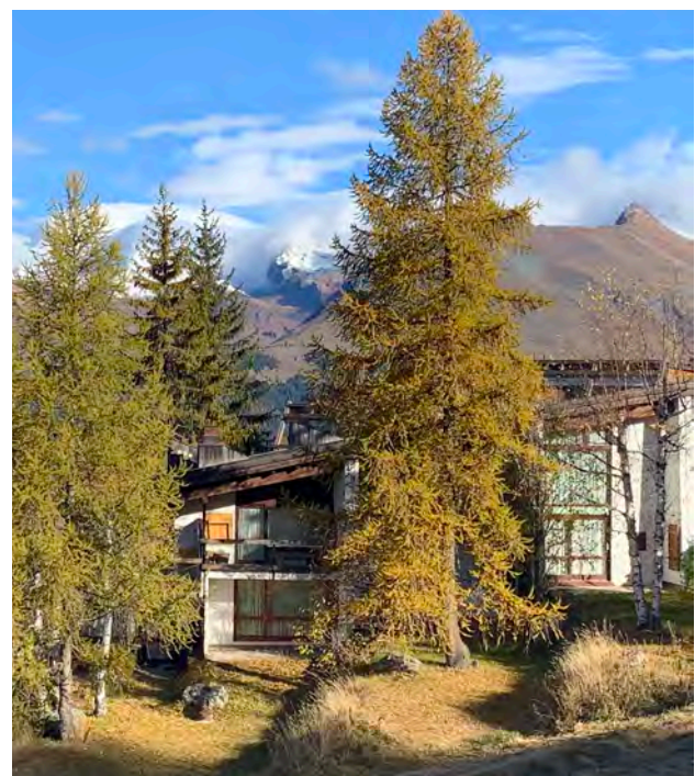
Structure apparente de La Rive
