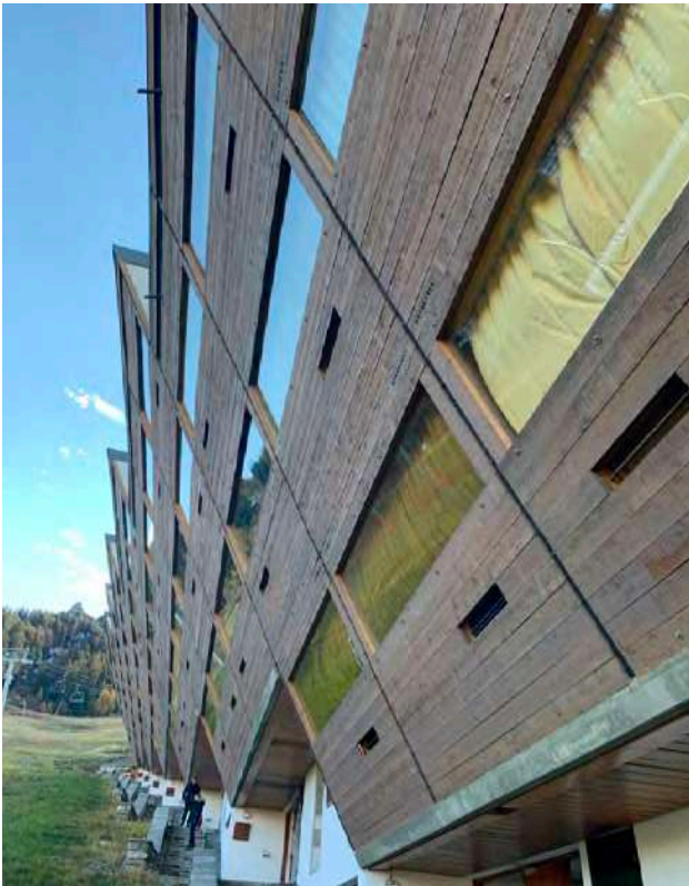
Les soubassements en béton, les façades en bois, les châssis fixe vitrés et les rideaux jaunes de La Cascade © archipat, octobre 2021
