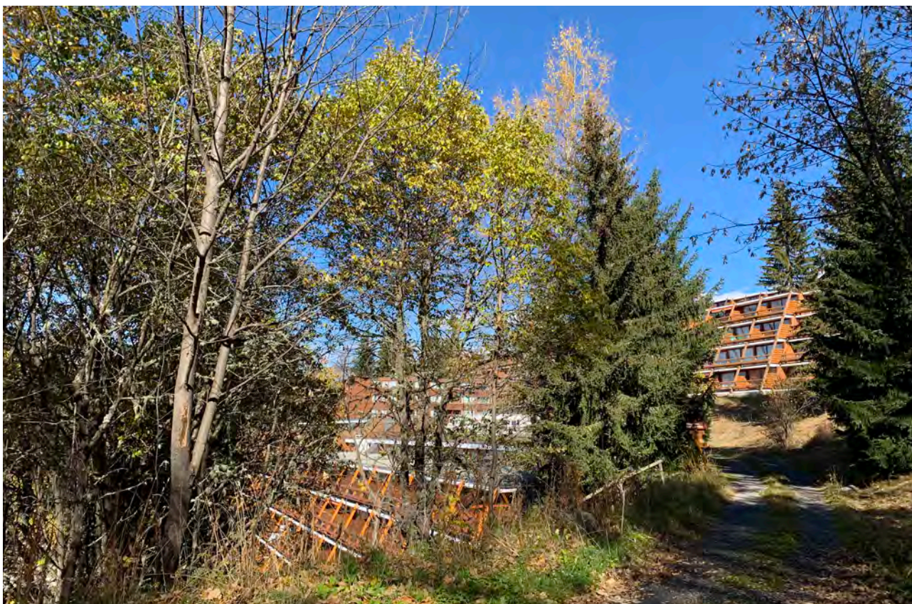
Les résidences de l'entité Versant Sud dans leur environnement © archipat, octobre 2021
