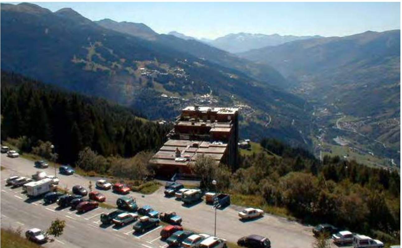
La toiture du Vaugella depuis l'amont © Région Rhône-Alpes, Inventaire général du patrimoine culturel © Ecole d'architecture de Grenoble - Lyon-Caen Jean-François - Salomon-Pelen Catherine
