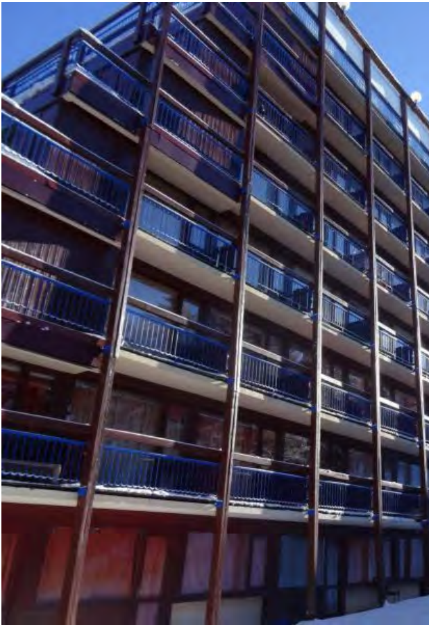
Menuiseries bois, serrurerie et bardages du Miravidi © archipat, janvier 2022
