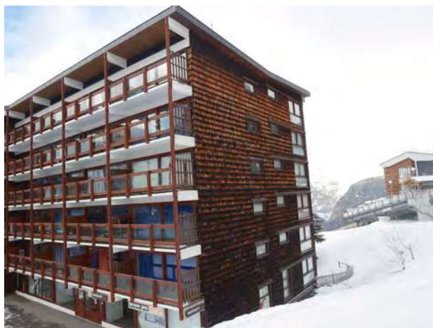
Façade sud et pignon de la résidence des Trois Arcs © archipat, janvier 2022
