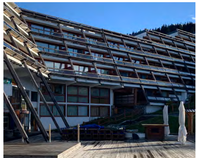
Le soubassement béton, les structures des balcons en bois et les menuiseries de La Cascade © archipat, octobre 2021
