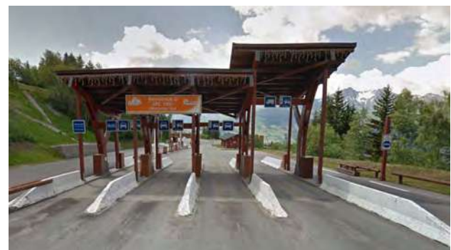
Portique d'entrée © Google, juin 2014
