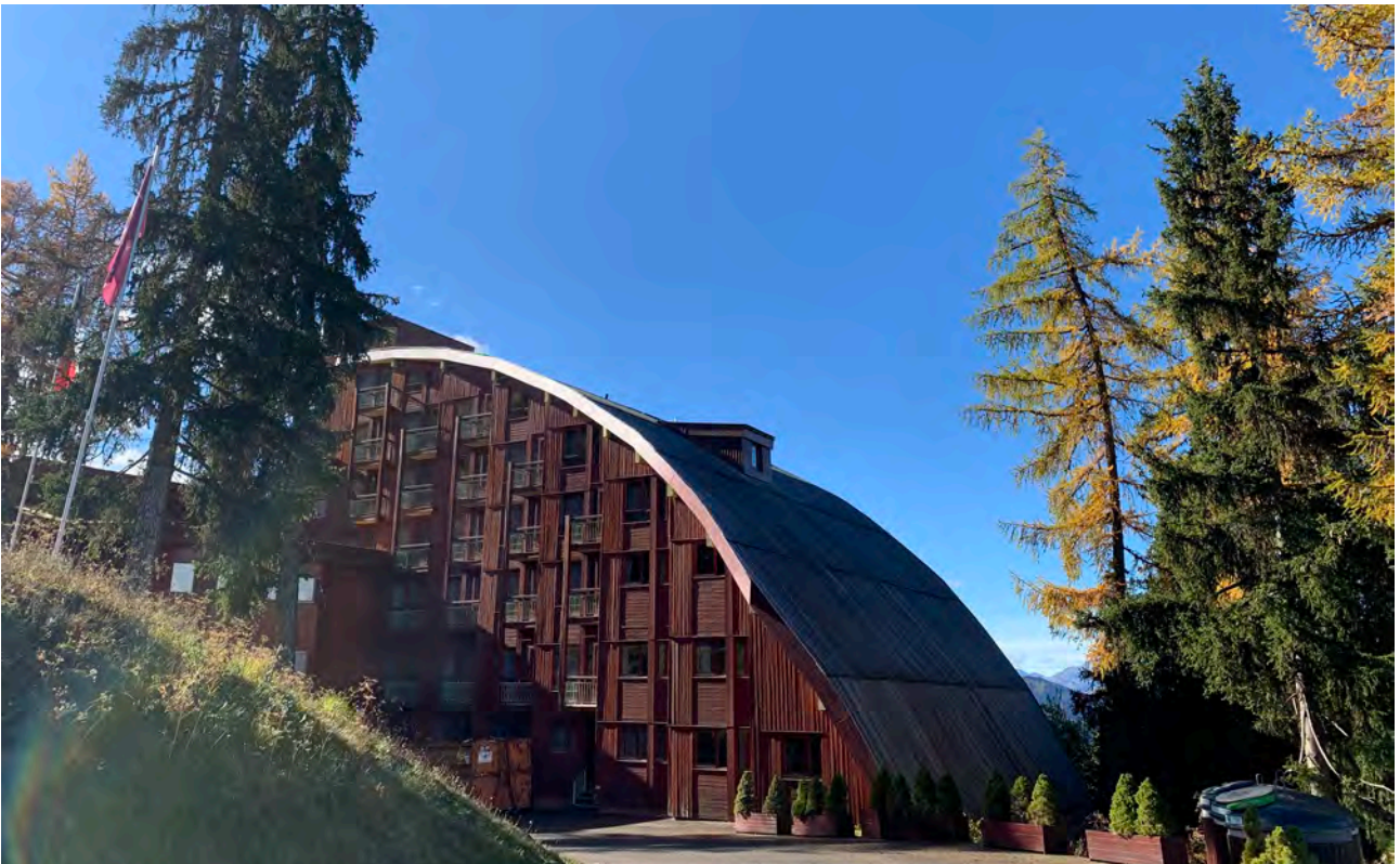
L'Hôtel Mercure émergeant de la pente et de la végétation © archipat, octobre 2021
