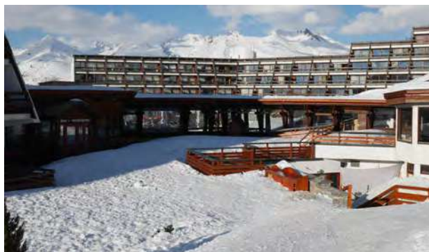
La surélévation de la galerie entre La Cache et La Rive depuis la Place des Trois Ours © archipat, février 2022
