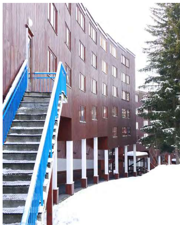
Façade nord-est © archipat, janvier 2022
