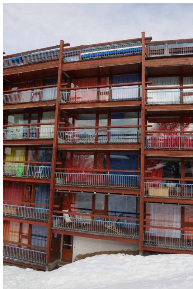
Composition d'une travée complète façade sud-ouest © archipat, janvier 2022
