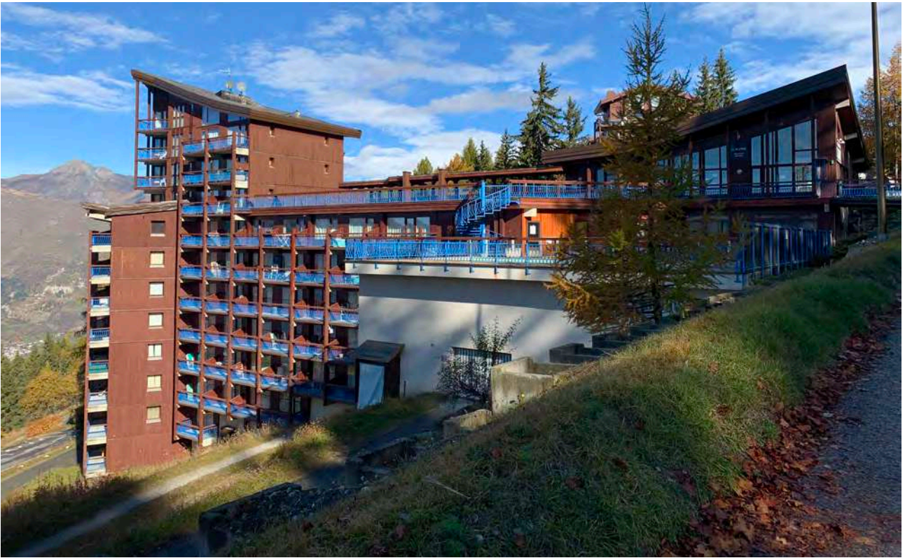
Le Ruitor : les garde-corps et rideaux trop clairs, les antennes et paraboles rapportées en toitures © archipat, octobre 2021
