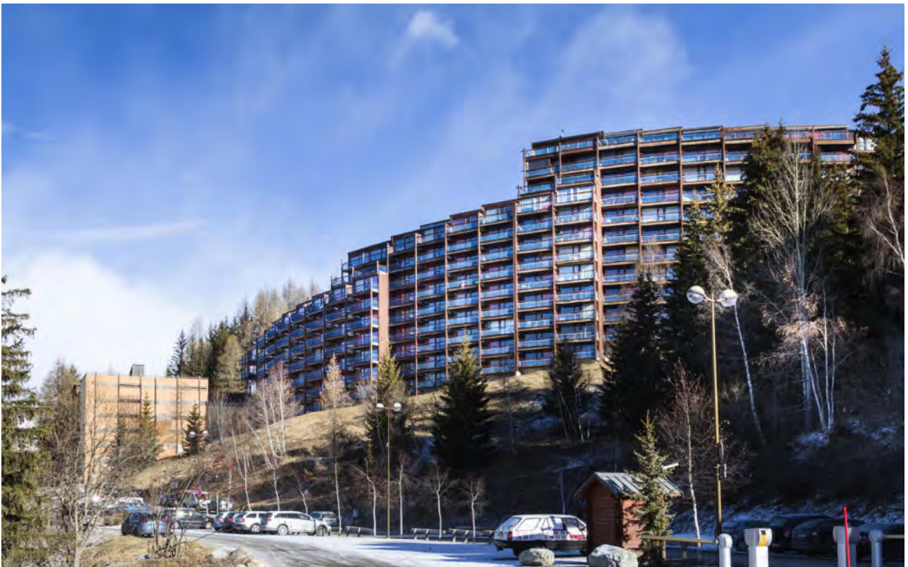
La Nova depuis l'aval
