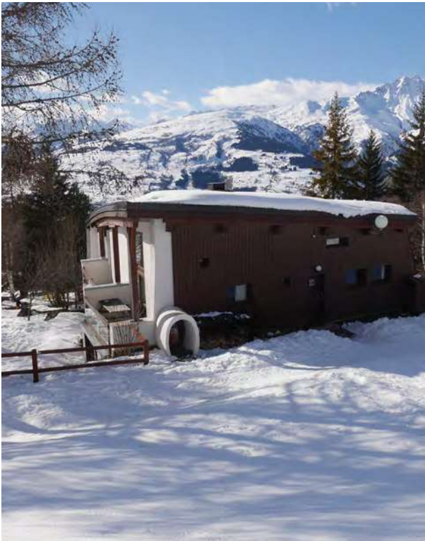
Les structures béton, les bardages et garde corps en bois de La Rive © archipat, février 2022
