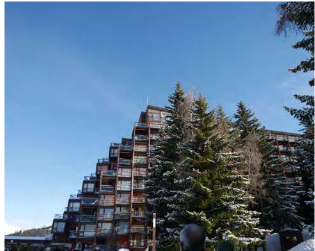
Résidence les Belles Challes © archipat, janvier 2022
