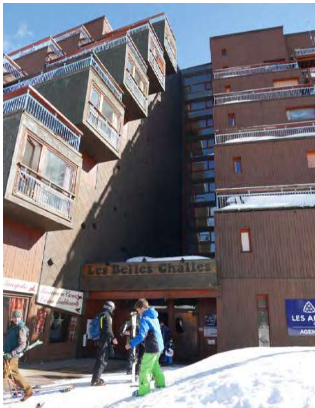
Pignon des Belles Challes © archipat, janvier 2022
