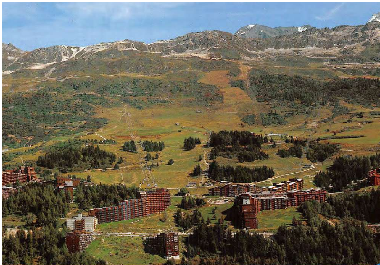
Vue aérienne d'Arc 1800 : La Nova dans son environnement urbain et paysager © Delcampe
