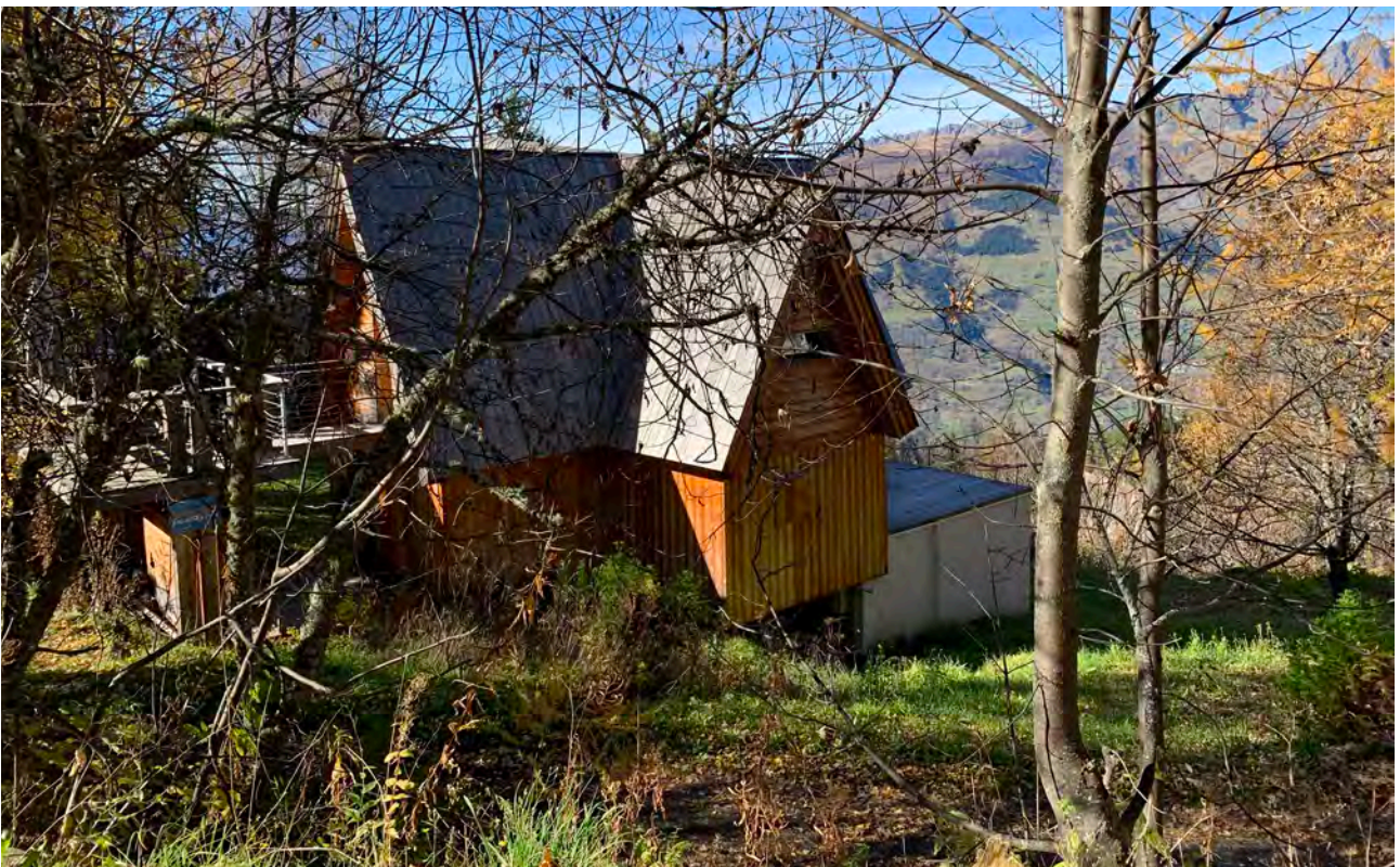
Extension du chalet au niveau du socle et création d'une terrasse sur la toiture de l'extension © archipat, octobre 2021
