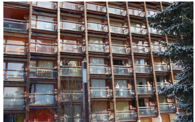
Les Belles Challes au Charvet © archipat, janvier 2022
