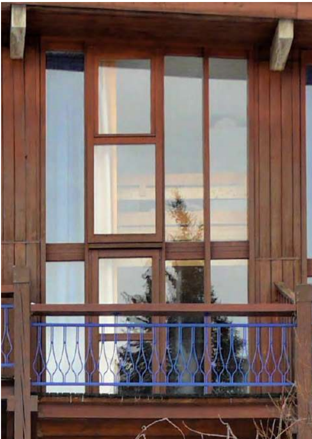
Un dispositif modifié : ouvrant, plancher de mezzanine prolongé avec nouveau garde-corps intérieur très présents © archipat, janvier 2022
