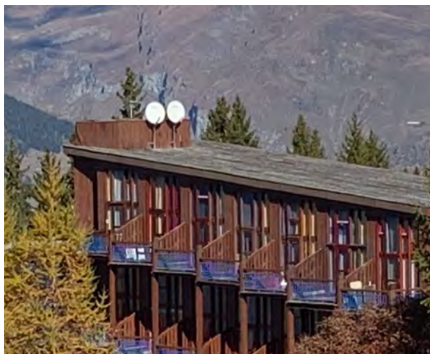
Les paraboles ajoutées en toiture © archipat, octobre 2021
