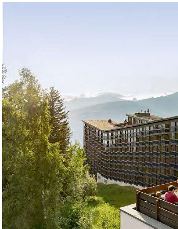
Antennes et paraboles en toiture © Hôtel du Golf
