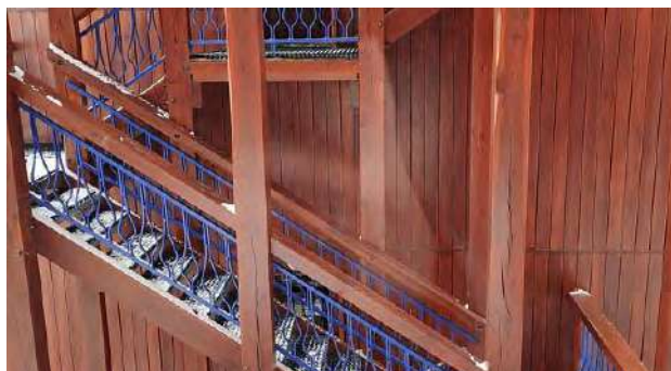
Bois des bardages et structures d'escaliers, métal des garde-corps © CAUE 73
