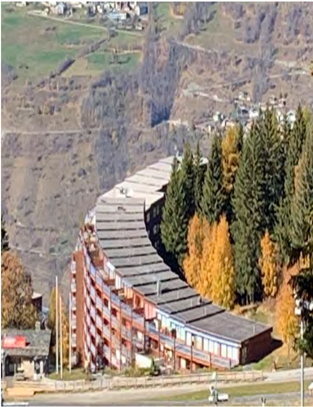
Toitures de La Nova © archipat, octobre 2021
