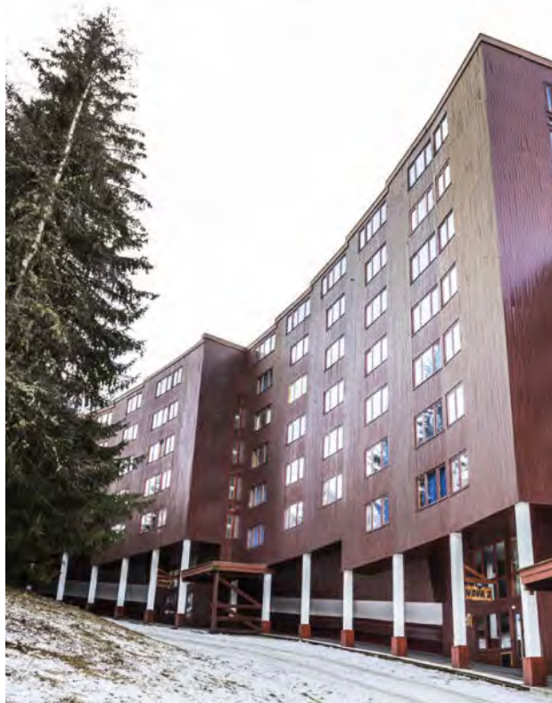
La Nova, façade nord-est
