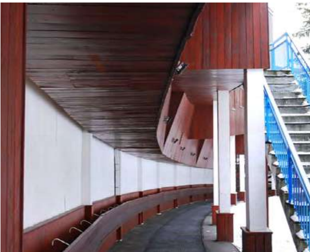
Bardage avec lasure de teinte brun rouge rapportée, béton enduit ou peint en blanc © archipat, janvier 2022
