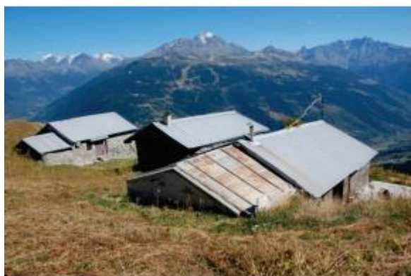
Groupement bâti d'alpage : Fornay
