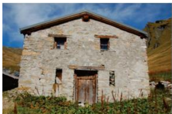
Façade principale : un des bâtiments de Plan Varrara
