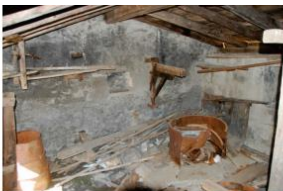
Espace de fabrication du fromage : La Marmotière
