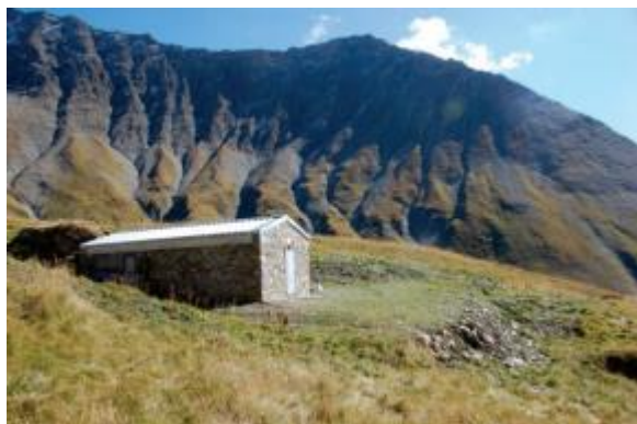
Talutage et terrassement à 2241 m : Le Bouillu des Mottets
