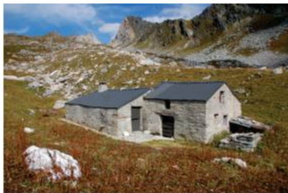
Bâtiment unitaire isolé : Le Petit Mont-Blanc
