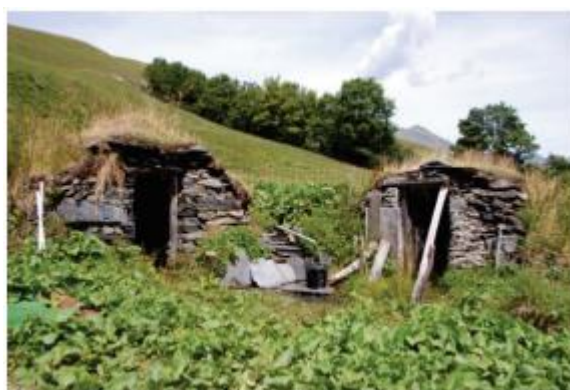
Deux « caveaux à lait » attenants : Le Sécheron
