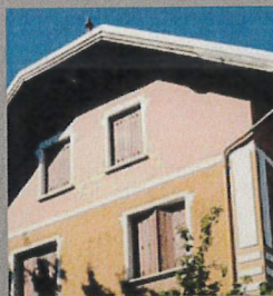
Les bandeaux soulignent la composition de la façade, Chemin de la greffière
