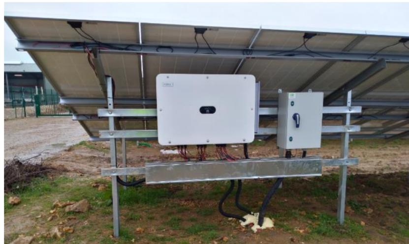
Figure 3 Onduleurs photovoltaïques fixés à la structure porteuse des modules (source : SOG SOLAR)
