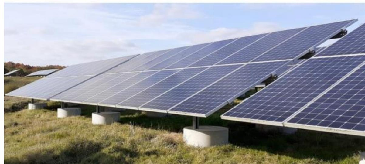
Figure 2 Photo structure photovoltaïque sur plot béton (source : Sydela Energie 44)
