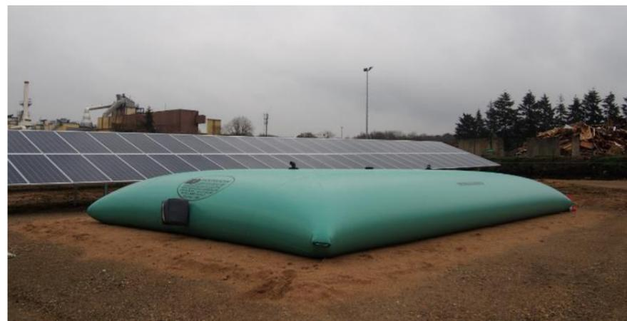
Figure 6 Réserve incendie souple (Source : SOG SOLAR)
