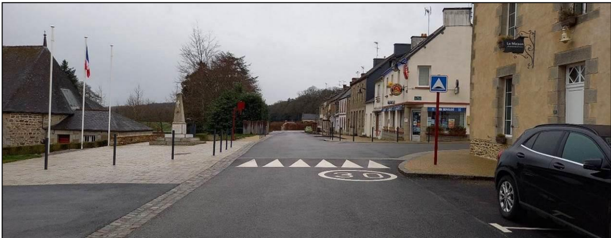
Aménagement récent de la voirie et des trottoirs
