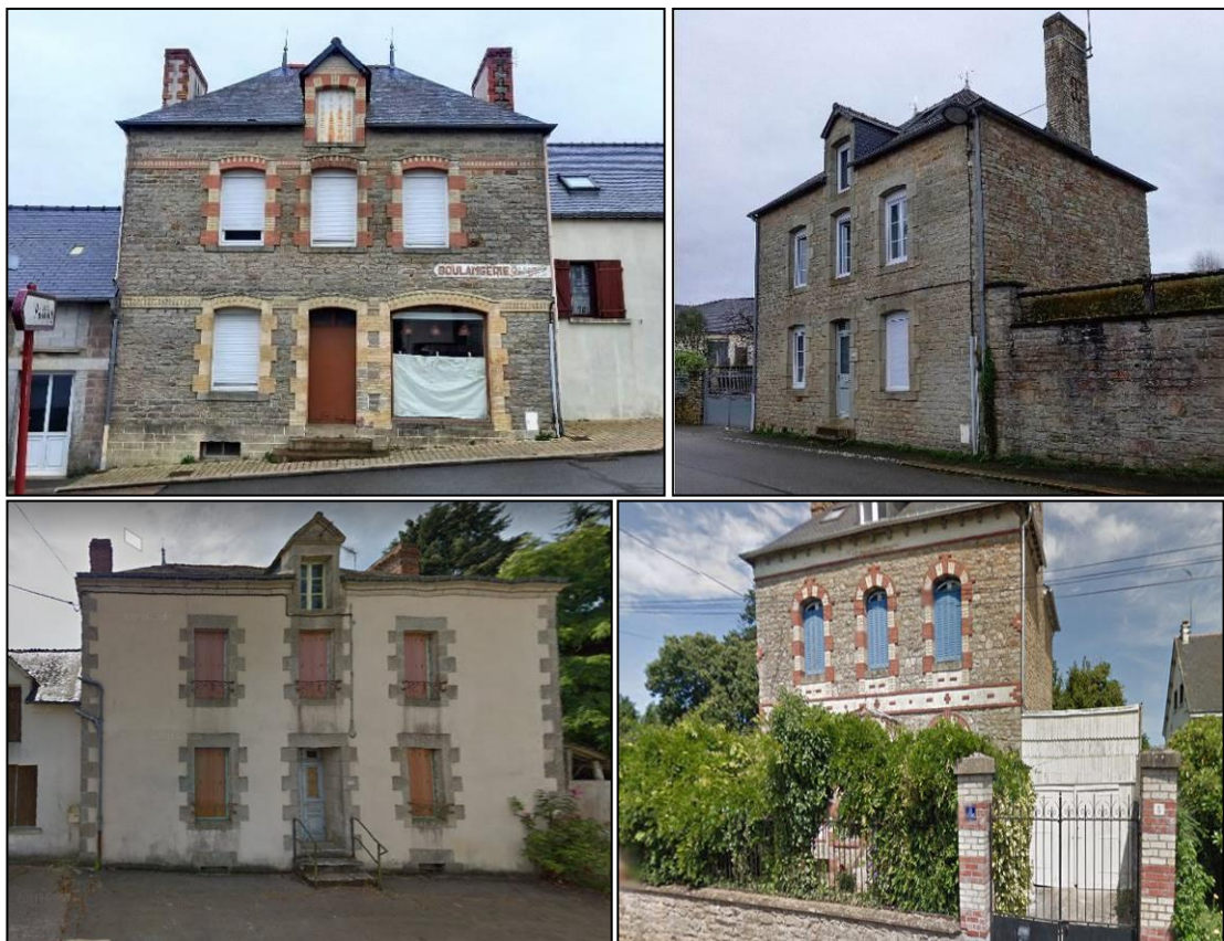
Toitures à quatre pans et lucarnes
