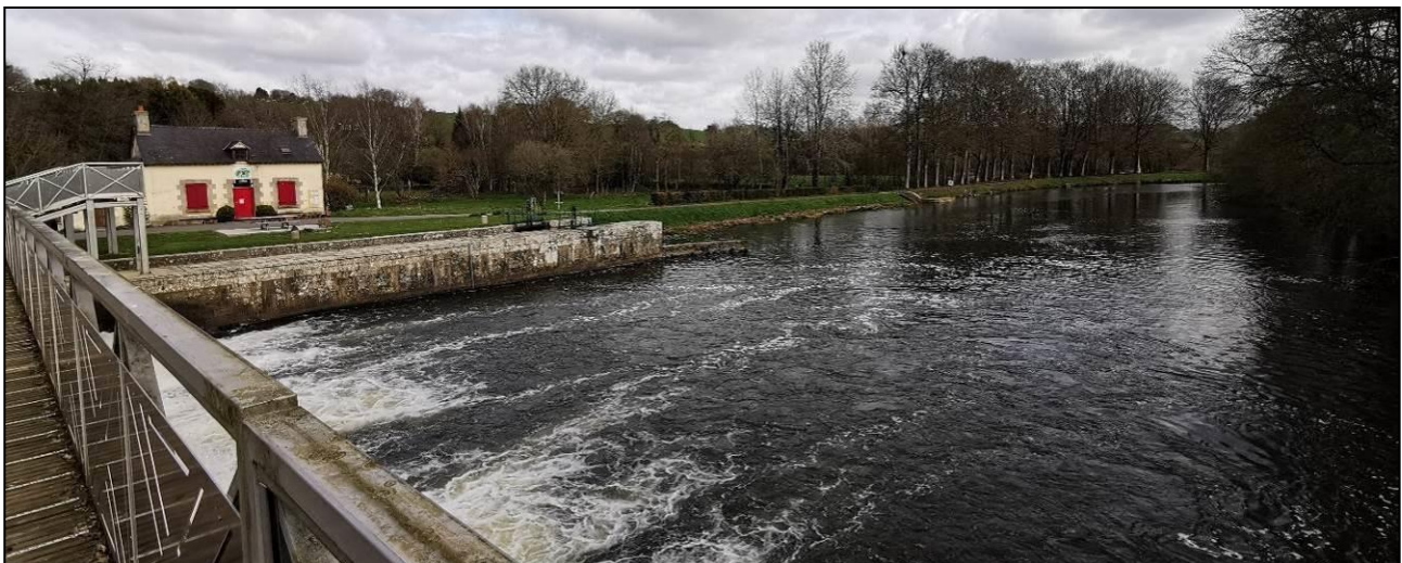
Écluse et passerelle du Rouvray
