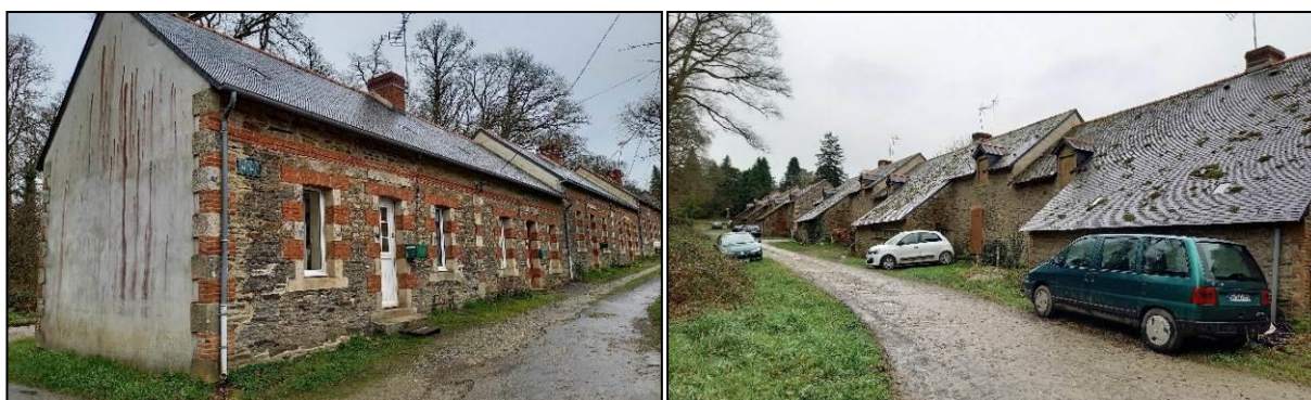
Habitat ouvrier, rue de la Cité
