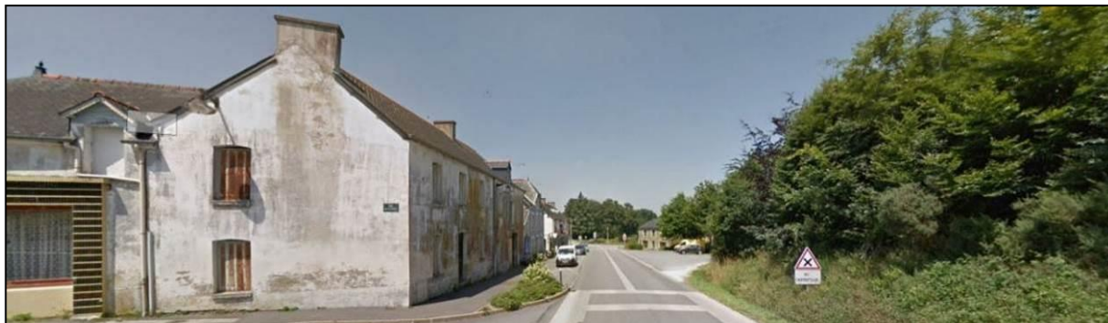
Front bâti continu, présence de logements vacants
