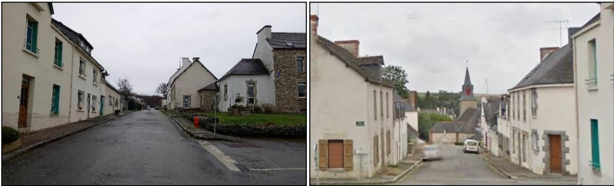
Voie secondaire : rue Charles de Janzé
