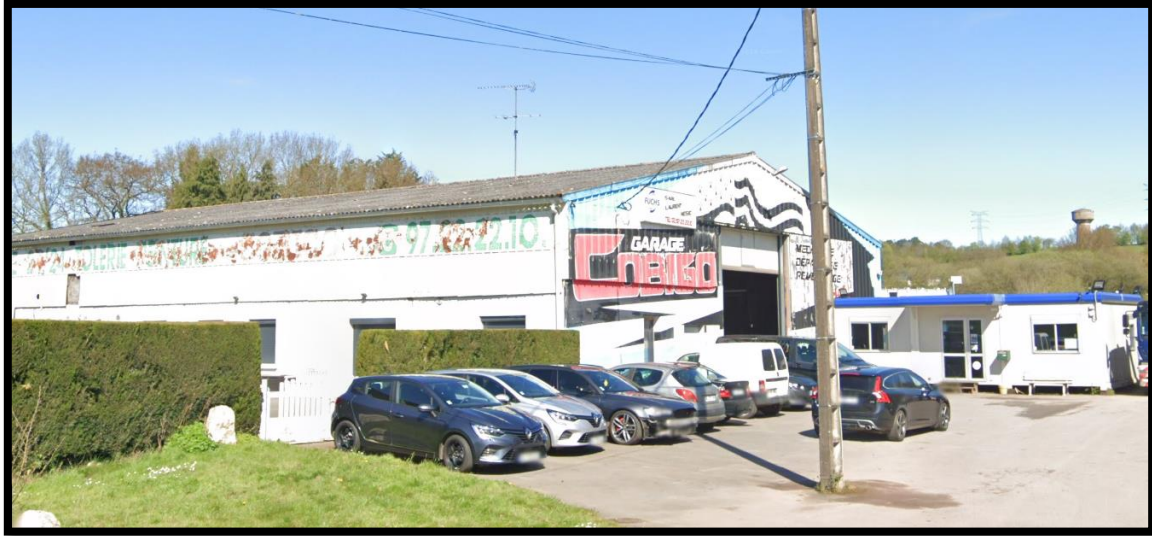
Bâtiment du garage Cobigo – source google street view
